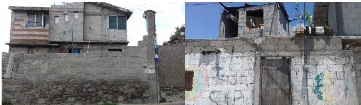
Figura 9. Características constructivas de dos viviendas que fueron encuestadas.
