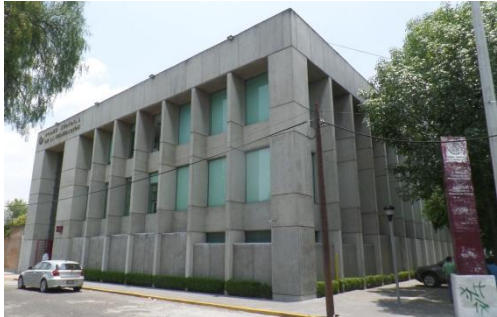
55.- Edificio sede de IBM (1979) actualmente oficinas del Poder Judicial de la Federación.
