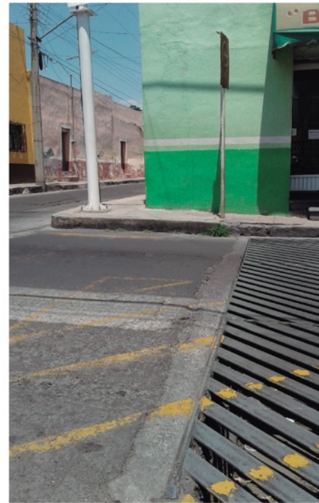
Fotografía 15. Obstáculos en la intersección (poste de acero, señalética vertical) en la calle
