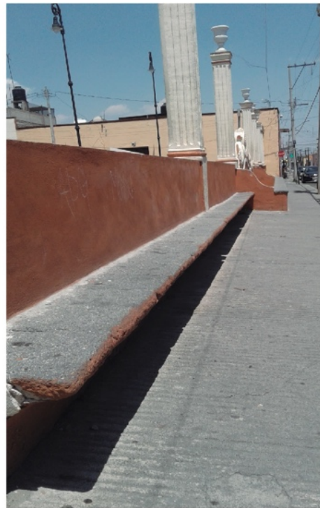
Fotografía 14. Elemento de concreto para sentarse, ubicado en la calle
