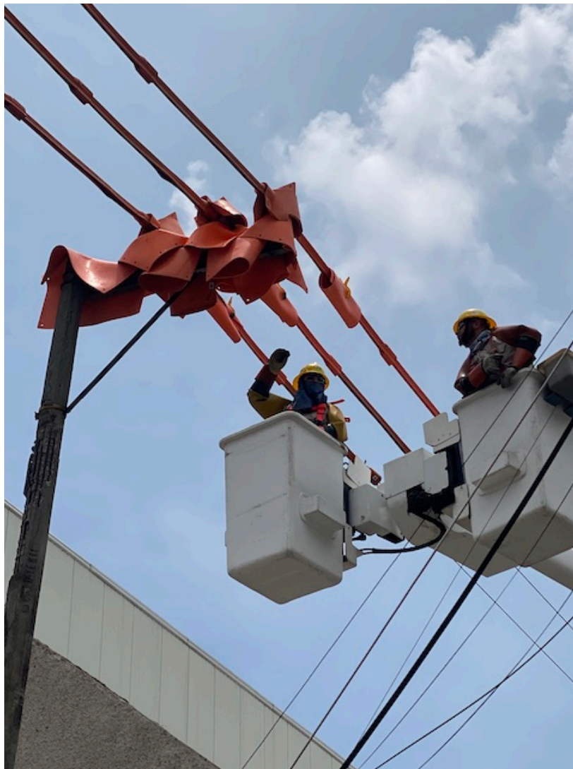
Figura 6.- Mantenimiento preventivo, cambio de aislamiento en líneas energizadas con conductores cubiertos.
