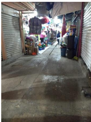
Imagen 17. Piso de concreto en pasillos
