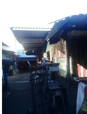
Imagen 18. Cubiertas de lámina galvanizada.
