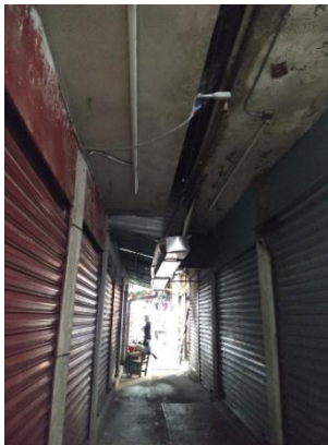
Imagen 14. Estructuras de concreto armado.
