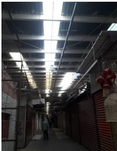
Imagen 23. Tuberías conduit y soportería en charolas de acero.
