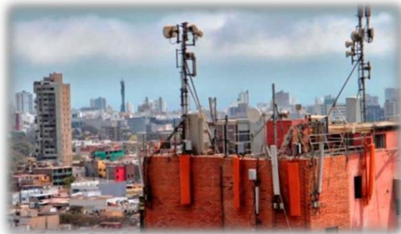
Figura A2 Sitio Roof Top existente
