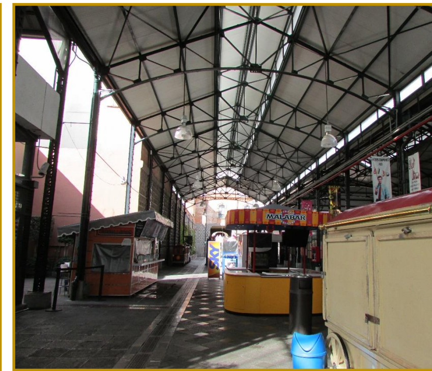
Zona de comercio dentro del Centro Comercial "La Victoria" en el centro histórico de la Ciudad de Puebla. (2013).
