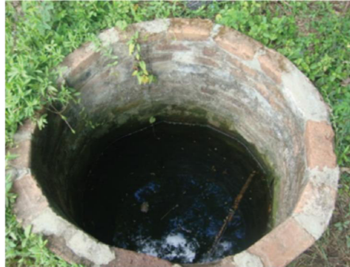
El abastecimiento de agua en esta zona, es a través de la creación de pozos y almacenamiento de agua pluvial; algunos de estos pozos se encuentran abiertos, convirtiendose en criaderos de moscos. [Toma por Ángel Alberto Moreno Aguilar, el 19/02/2014]
