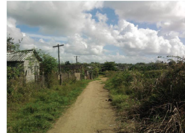
La instalación de la infraestructura se encuentra deteriorada por el paso del tiempo, además que la vegetación prevalece en gran parte de esta zona. [Toma por Lucero Bolaños Fortiz, el 19/02/2014]
