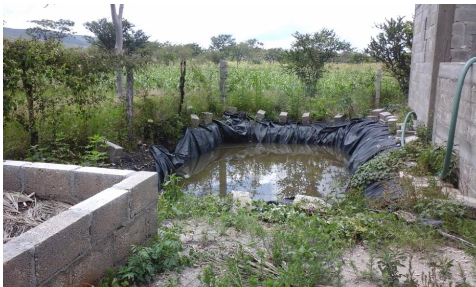
Figura 53. Hoya de captación para recolectar agua de lluvia y emplearla a través del sistema de riego por goteo. San Felipe Otlaltepec. Puebla, México. 2014.
