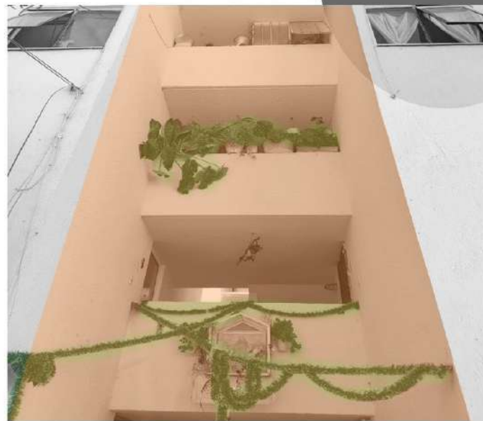
El área de escalera funciona como el primer espacio de interacción.
