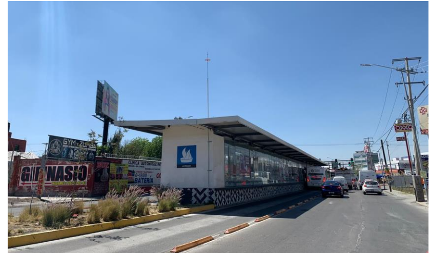
Figura 14: parada RUTA 3, fotografía tomada desde Boulevard Capitan Carlos Camacho Espiritu con dirección a Boulevard Valsequillo, Sofía Velazquez Rodriguez, 2020.
