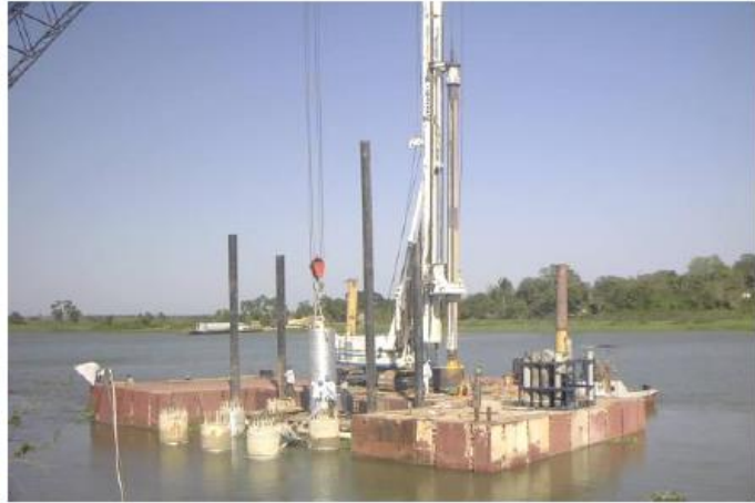
COLOCACIÓN DE TUBO ESPIRODUCTO.
