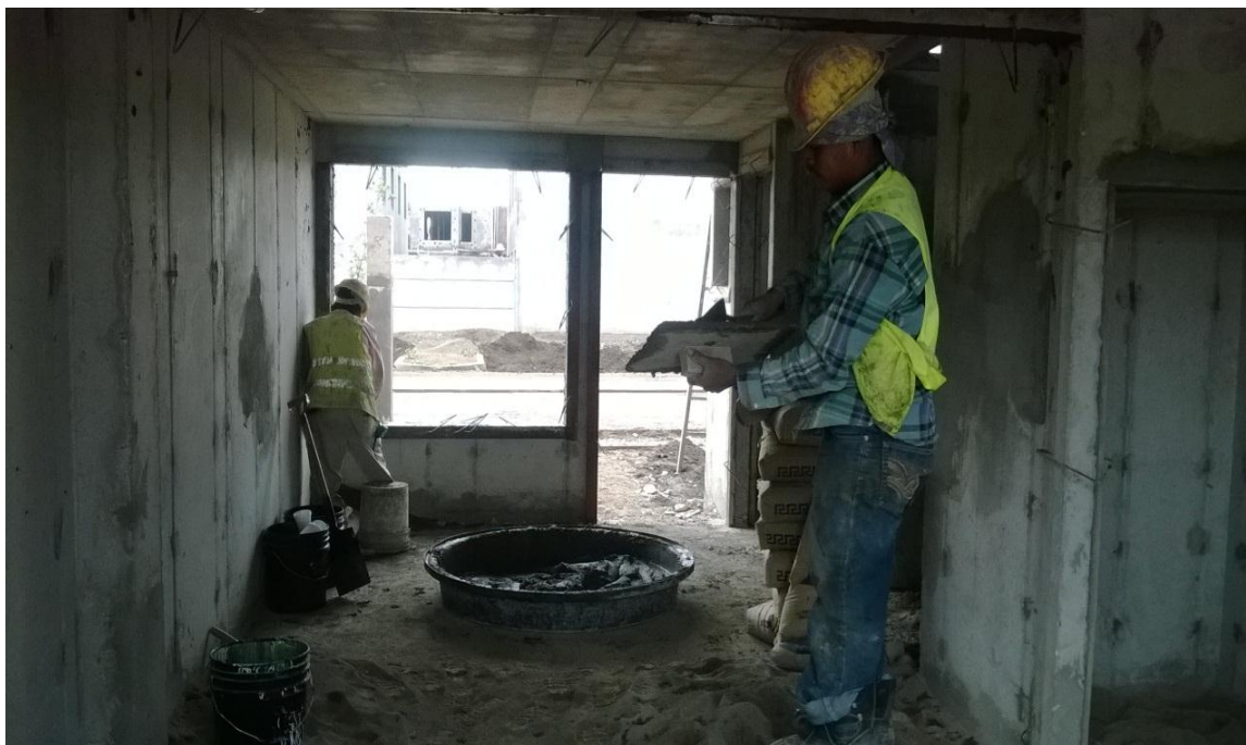
Fuente: propia, albañilerías en el perfilado de boquillas de puertas y ventanas, Huejotzingo Puebla, ATV
