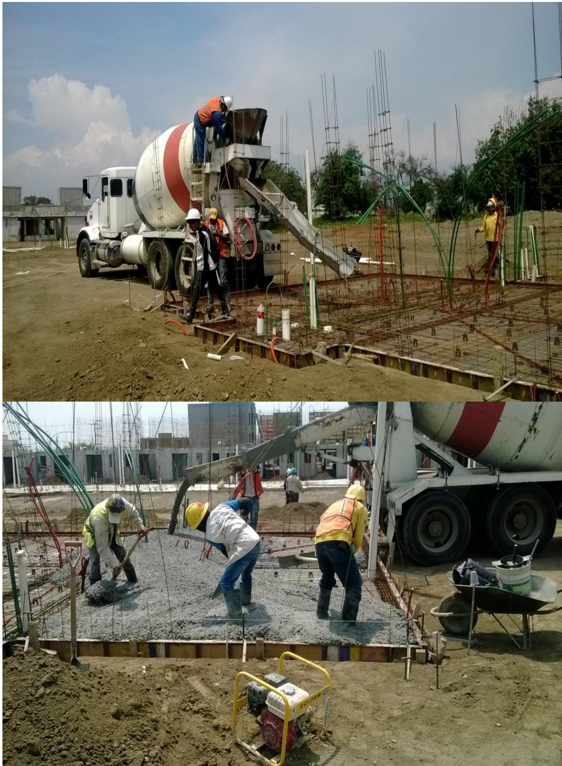
Fuente: propia, vaciado de concreto en cimentación, consorcio ARA Huejotzingo Puebla ATV
