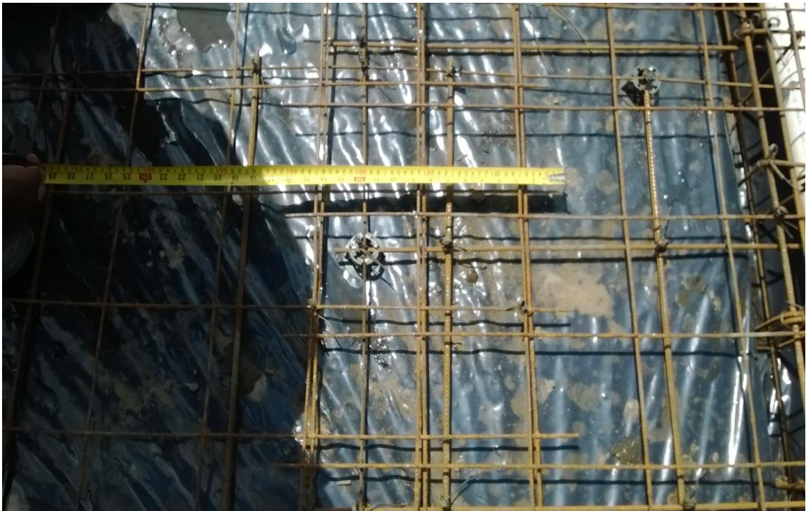
Fuente: propia, revisando empalmes de malla en cimentación, Huejotzingo Puebla, consorcio ARA ATV
