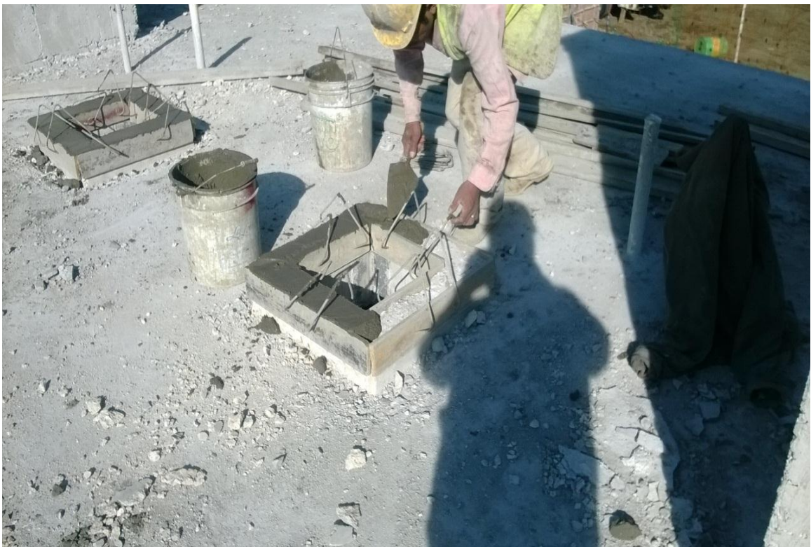
Fuente: propia, albañilería, emboquillado con mortero del domo en azotea, Huejotzingo, Puebla, ATV
