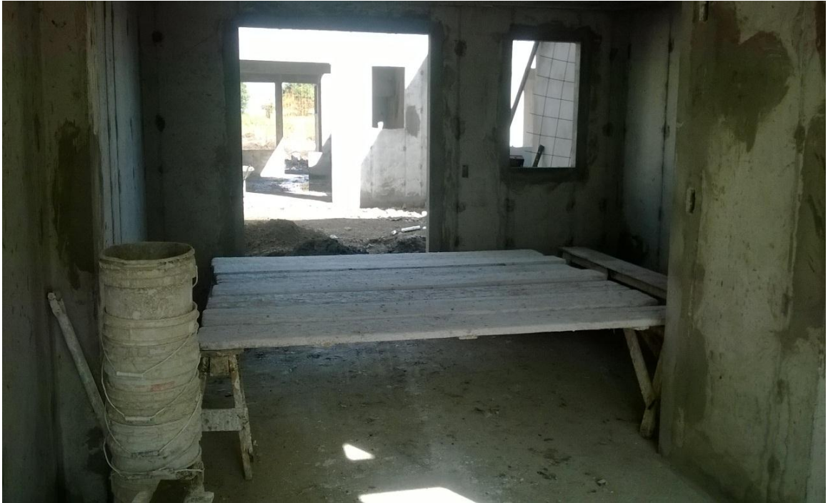
Fuente: propia, preparando el área con tendido para aplicación del yeso interior, Huejotzingo Puebla, ATV
