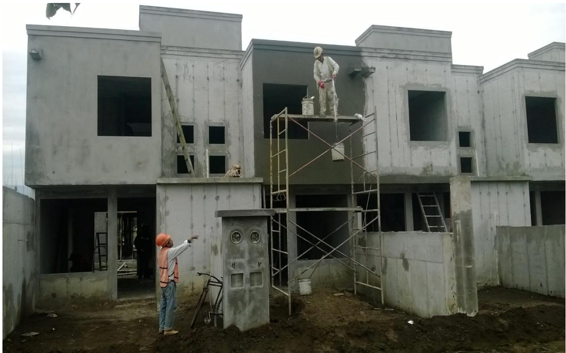
Fuente: propia, albañilerías, aplicación de afine en fachadas después de las boquillas, Huejotzingo Puebla, ATV
