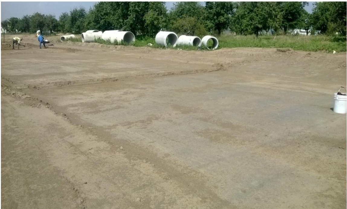
Fuente: propia, plataforma ya compactada, entregada y recibida, Huejotzingo Puebla, consorcio ARA ATV
