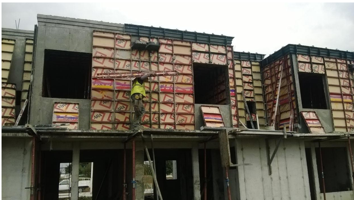
Fuente: propia, desmonte y traspaso de cimbra con tendido en primer nivel, Huejotzingo Puebla, consorcio ARA ATV
