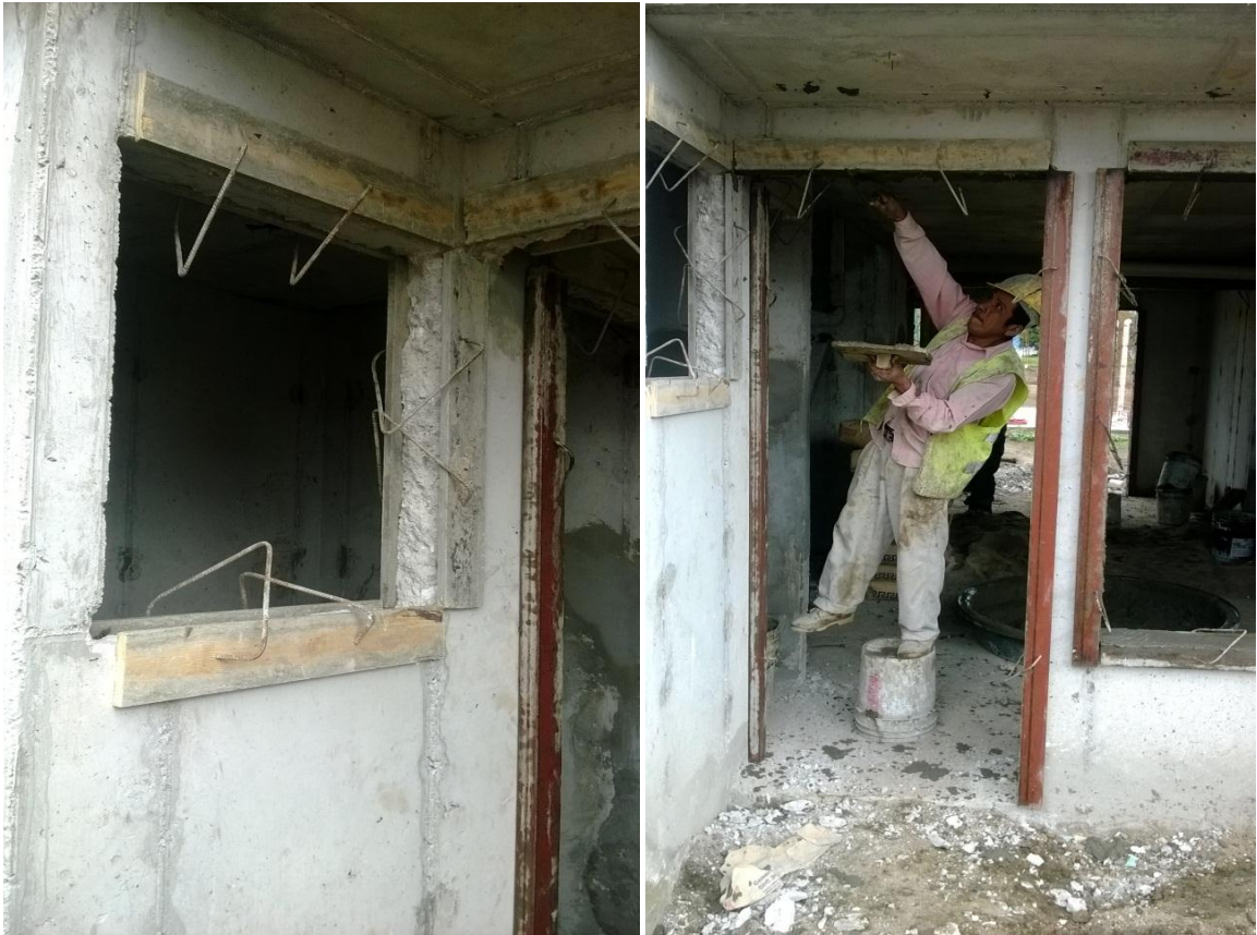
Fuente: propia, mortero cemento- arena para boquillas de puertas y ventanas, Huejotzingo Puebla, ATV
