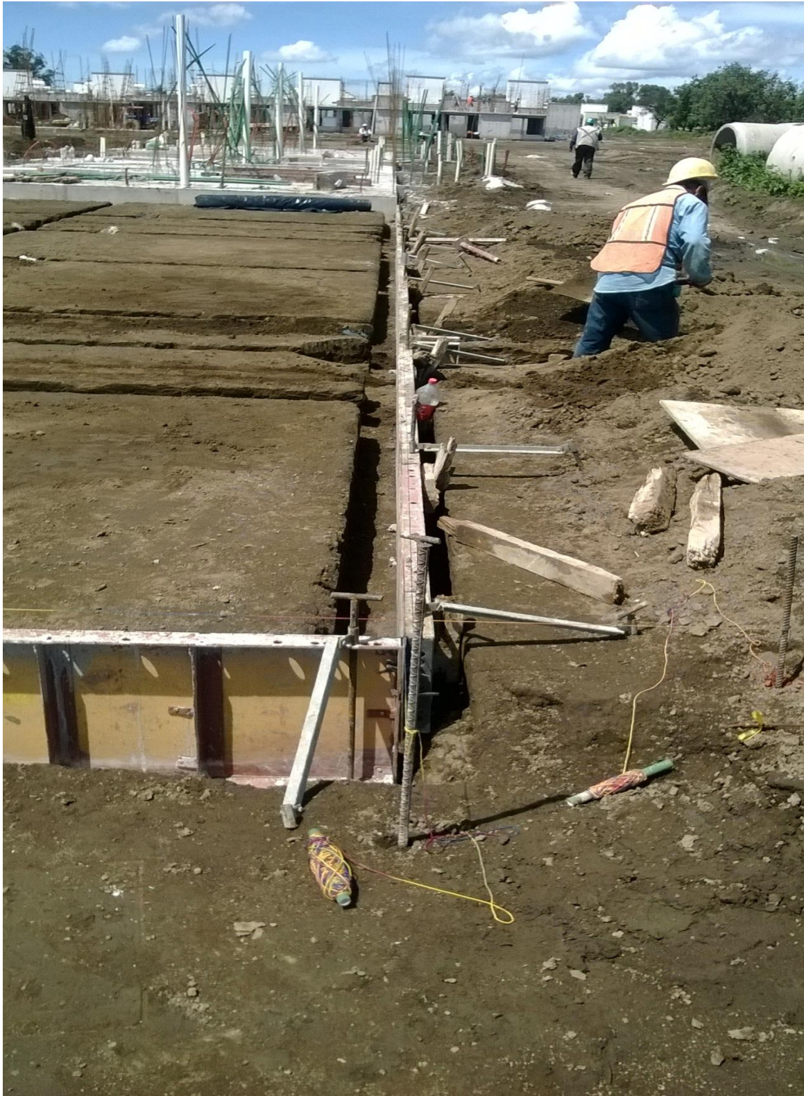
Fuente: propia, apuntalamiento y cimbrado de plataforma, Huejotzingo Puebla, consorcio ARA ATV
