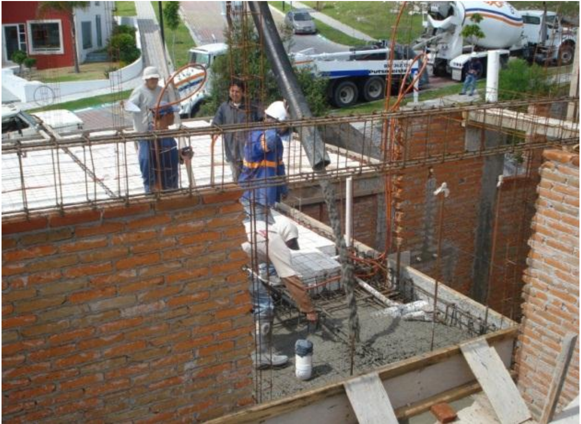
Fuente: propia, edificación y colado de entepiso, concreto premezclado, residencia en la calera, Puebla. Puebla ATV
