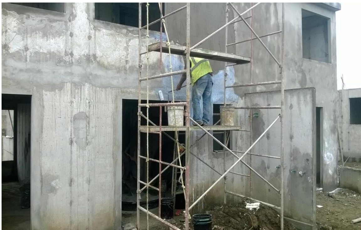
Fuente: propia, aplicación de adecon, para mejor agarre del mortero con el muro de concreto, Huejotzingo Puebla, ATV
