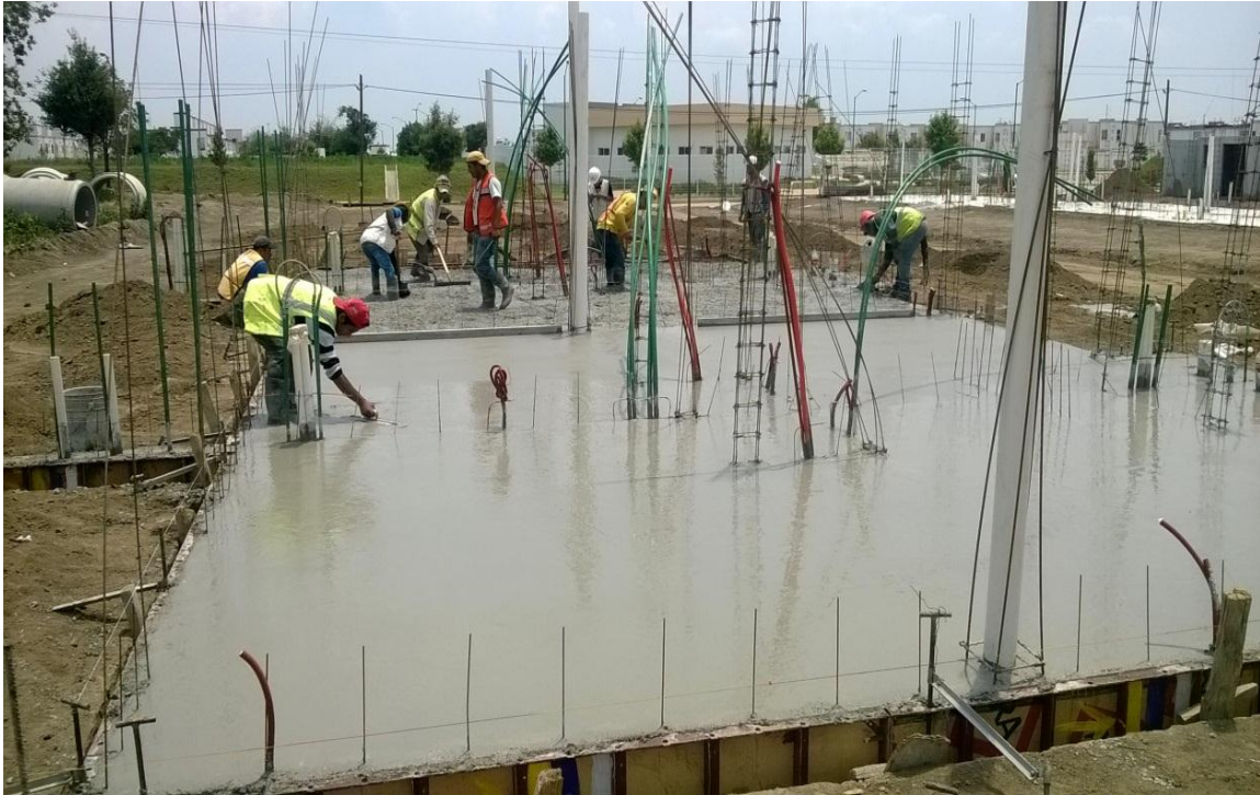
Fuente: propia, pulido de cimentación, atrás del colado, Huejotzingo Puebla, consorcio ARA ATV
