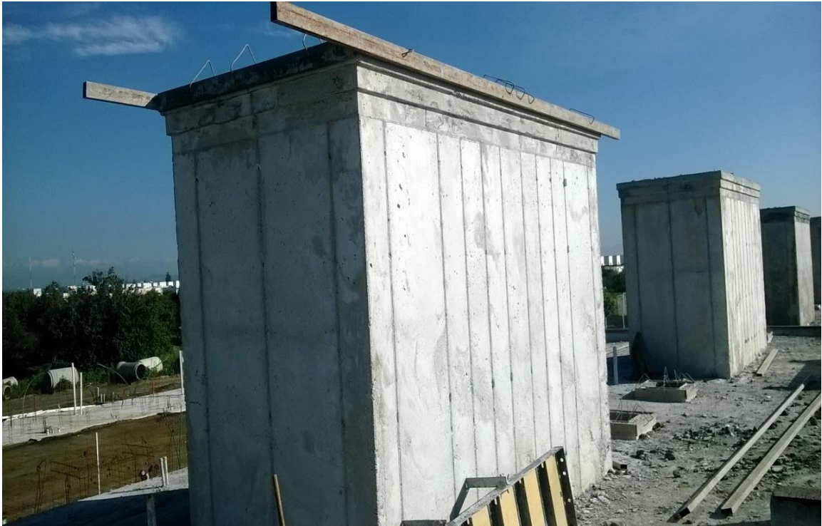
Fuente: propia, albañilerías, preparado con perfiles del torreón en azotea para afinarse, Huejotzingo Puebla, ATV
