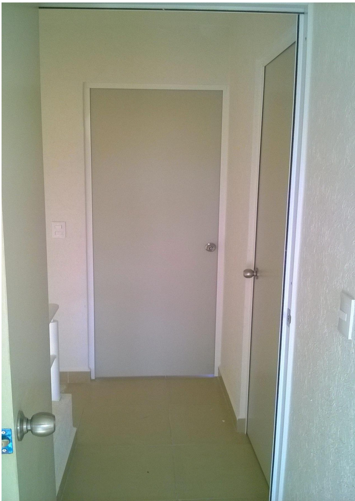
Fuente: propia, instalación de puertas de intercomunicación, en casa terminada y entregada Huejotzingo Puebla ATV
