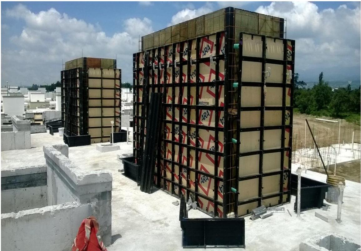
Fuente: propia, cimbrado del armado del torreón en azotea, Huejotzingo Puebla, consorcio ARA - ATV
