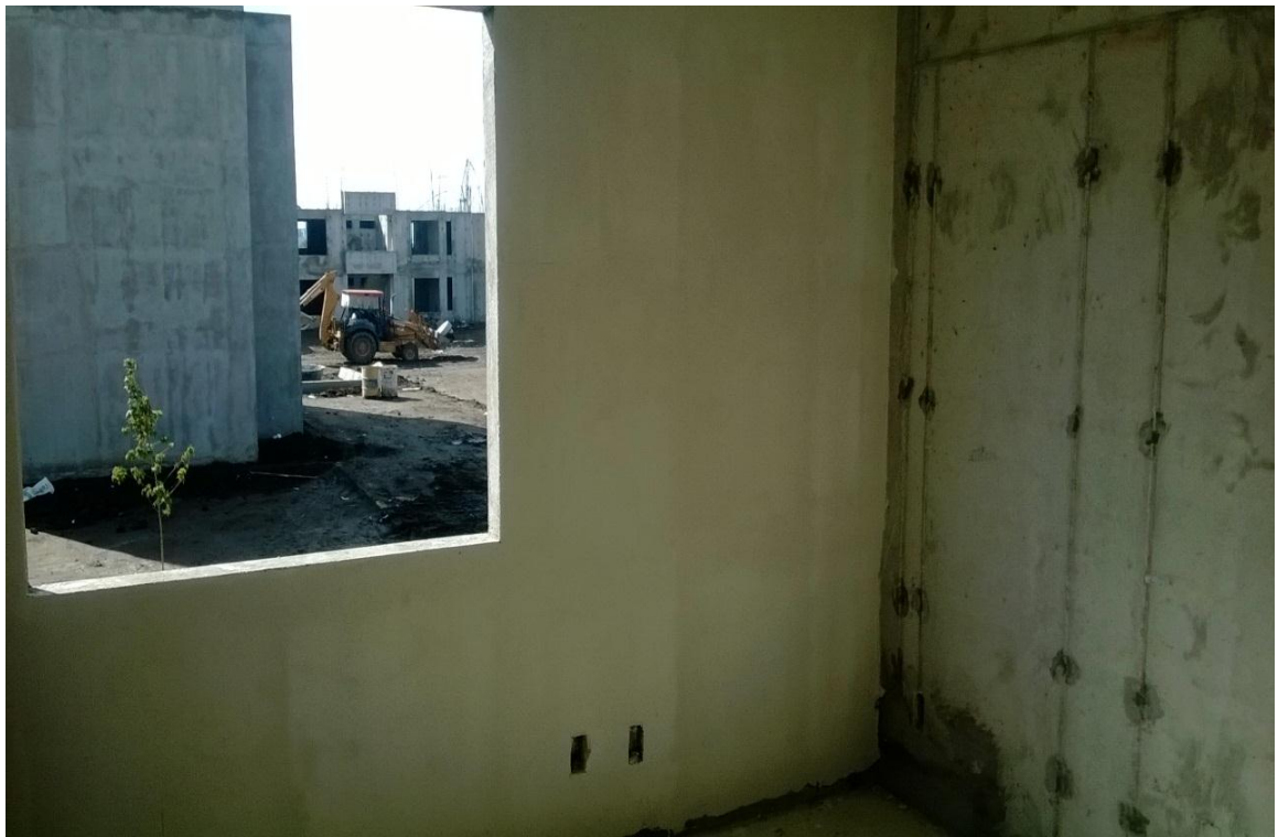
Fuente: propia, aplicación de yeso en muro de recamara, planta alta, Huejotzingo Puebla, ATV
