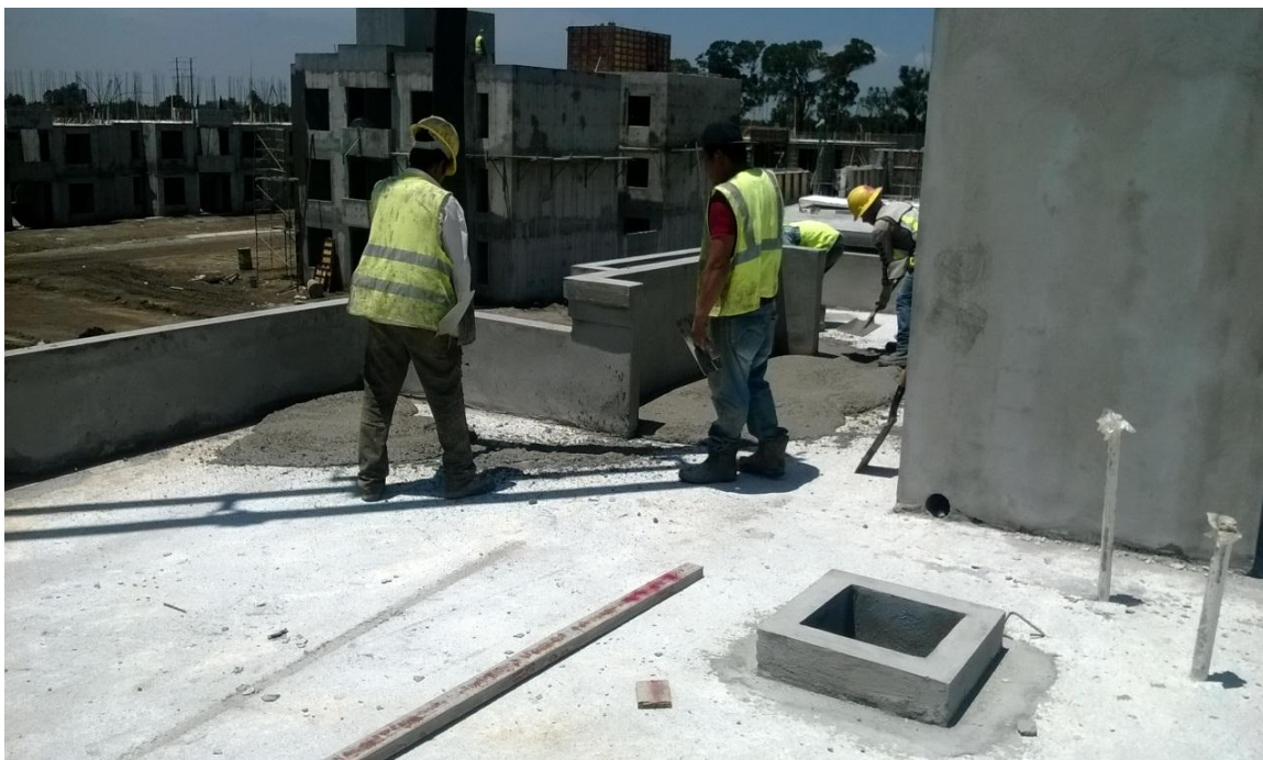
Fuente: propia, vaciado del mortero para los entortados y chaflanes en azoteas, Huejotzingo Puebla ATV
