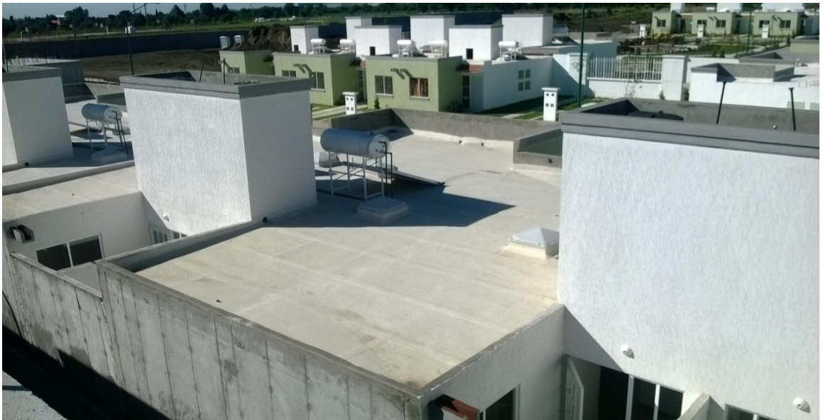
Fuente: propia, azotea impermeabilizada, instalación de calentadores, tinacos y domos, Huejotzingo Puebla ATV
