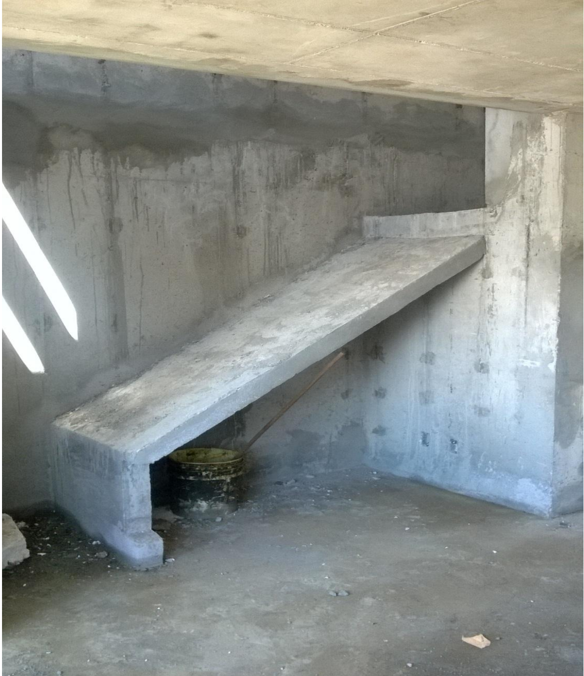
Fuente: propia, colado de la rampa de escalera, sin escalones, Huejotzingo Puebla, ATV
