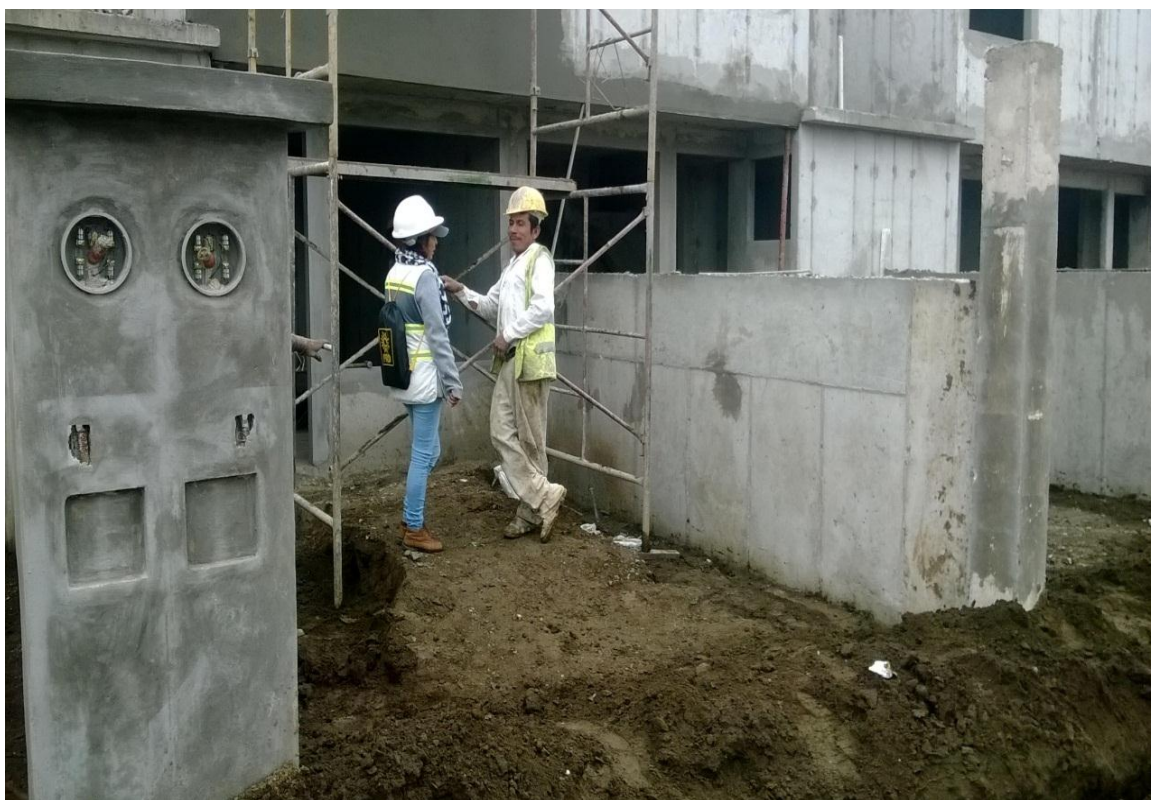
Fuente: propia, bodeguera con el afinador, pidiendo el material para el mortero del afine, Huejotzingo Puebla, ATV
