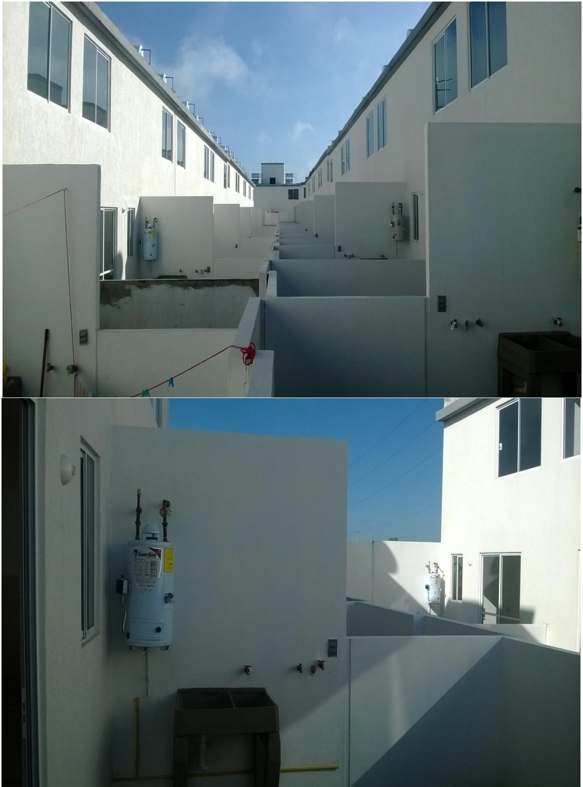
Fuente: propia, bardas pintadas de patios y entregadas con instalaciones y accesorios, Huejotzingo Puebla, ATV
