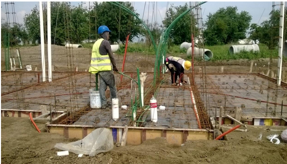
Fuente: propia, organización en cimentación, plomero y fierro, consorcio ARA Huejotzingo Puebla ATV
