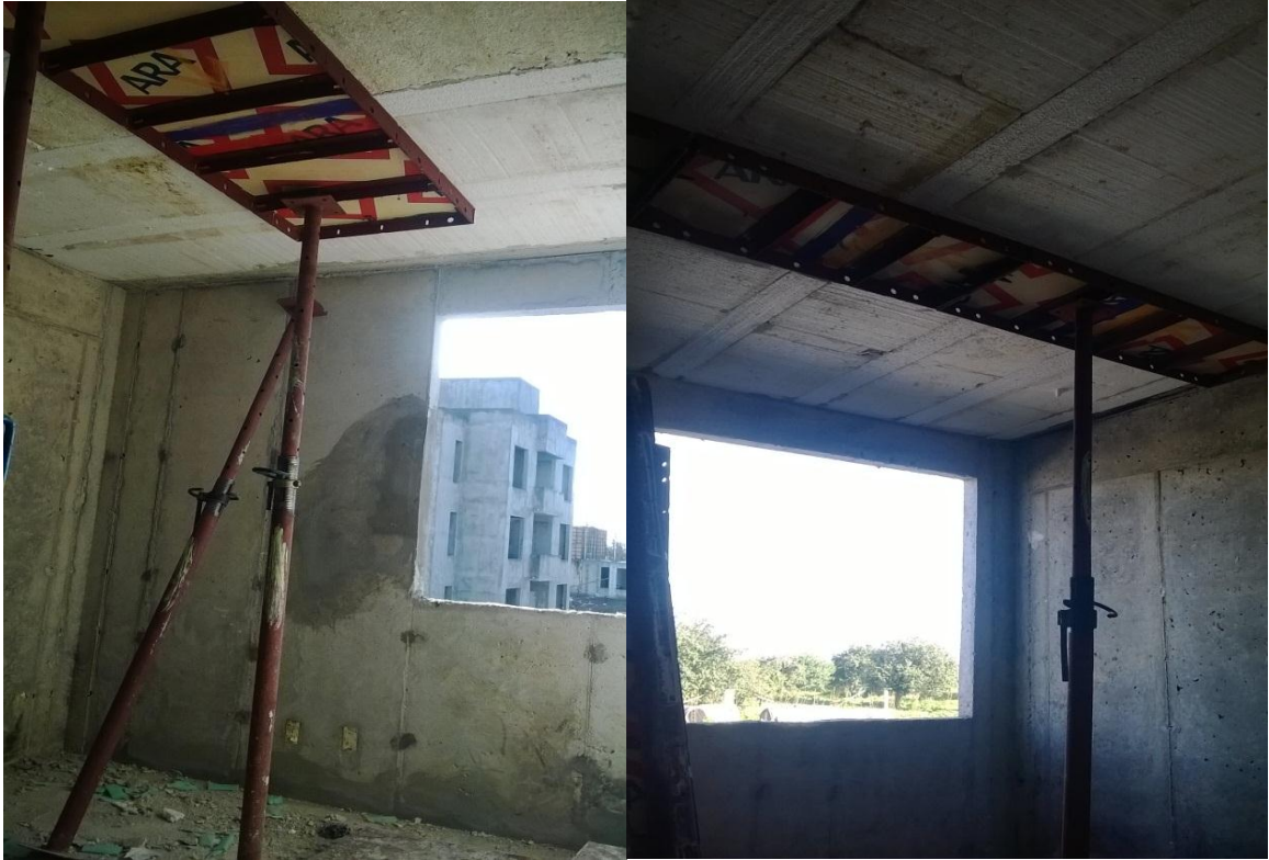
Fuente: propia, ejemplo de apuntalamiento central de lozas, Huejotzingo Puebla, consorcio ARA ATV
