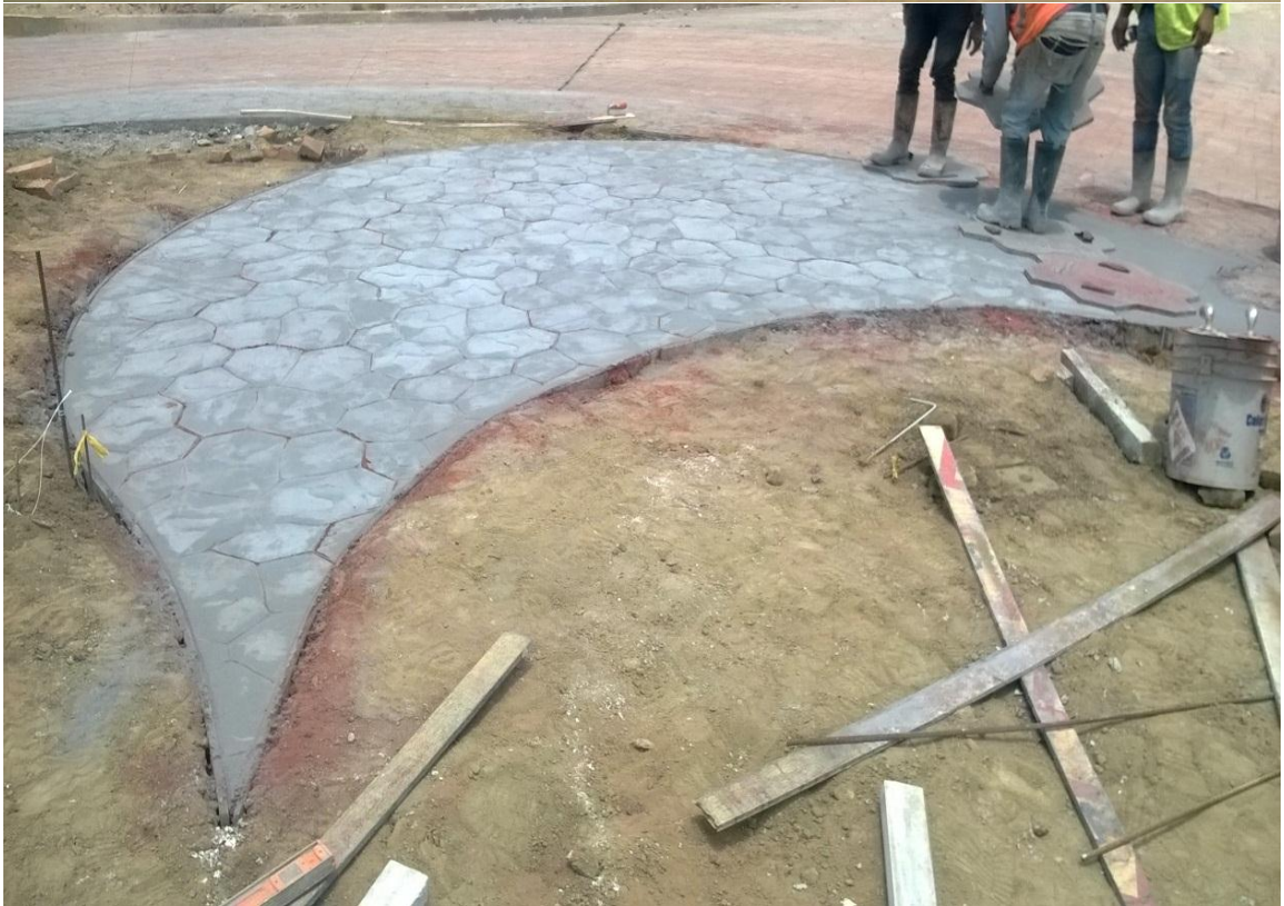
Fuente: propia, colado de estampados con color y concreto, Huejotzingo Puebla, consorcio ARA ATV
