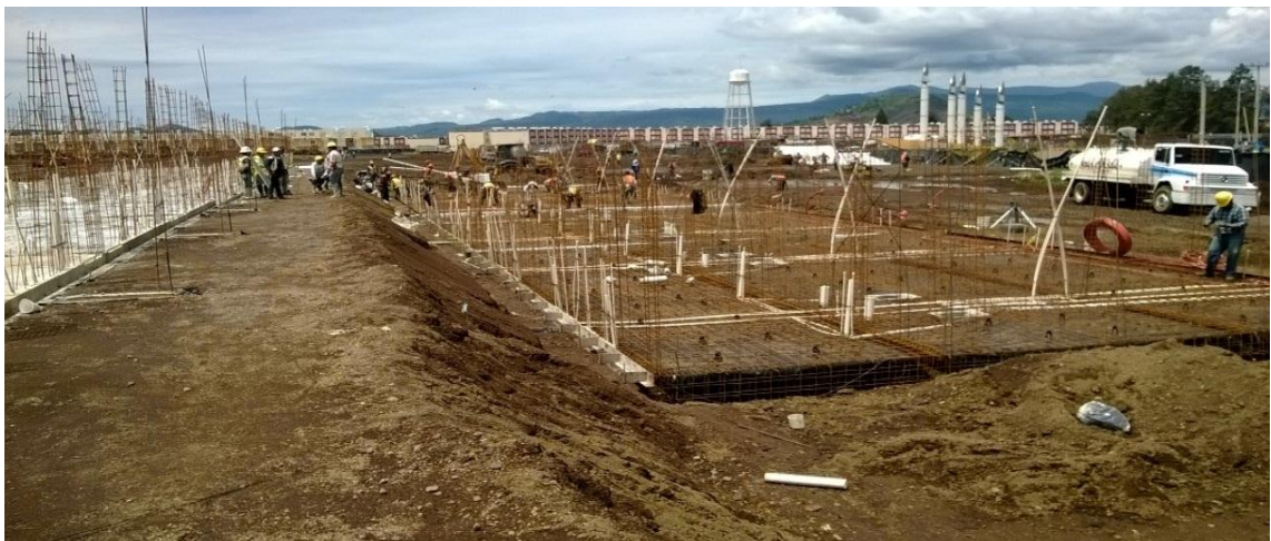
Fuente: propia, preparado para colado de cimentaciones en Chalco estado de México, grupo SADASI ATV
