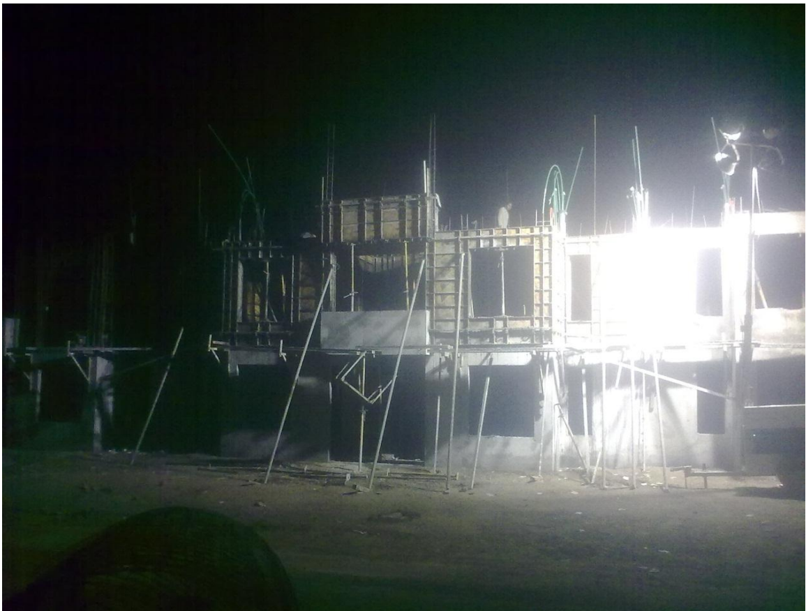
Fuente: propia, preparado para colar loza azotea y muro primer nivel, Huejotzingo Puebla, consorcio ARA ATV
