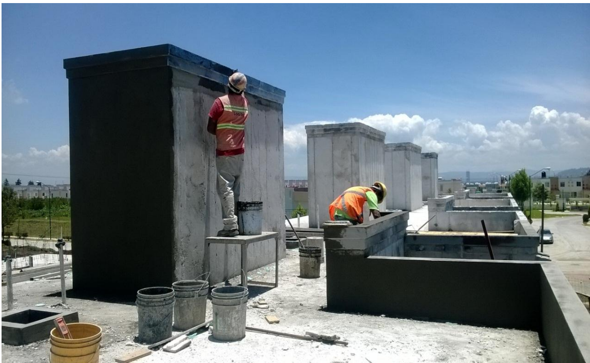
Fuente: propia, afinado con mortero en torreones azoteas con aplicación de adebon, Huejotzingo Puebla ATV
