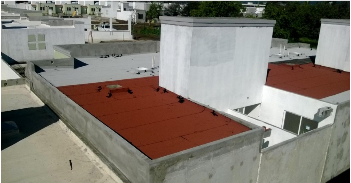
Fuente: propia, imagen del proceso de instalación de impermeabilizante en azotea, Huejotzingo Puebla, ATV
