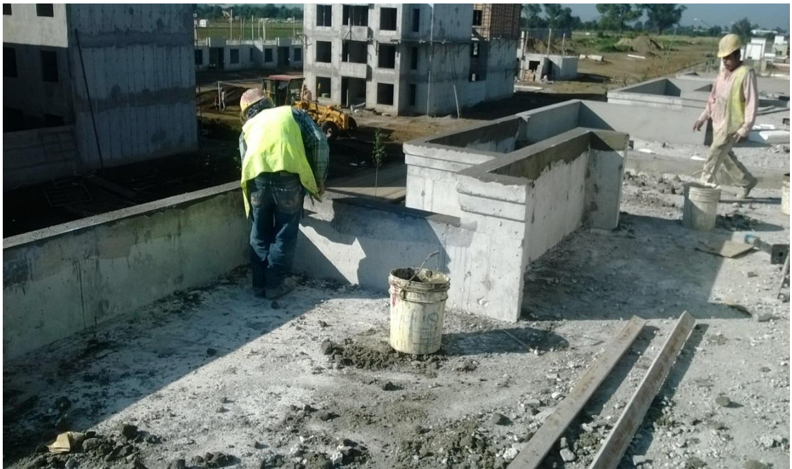
Fuente: propia, perfilado y emboquillado de aristas en pretil de azotea y fachada principal, Huejotzingo Puebla, ATV
