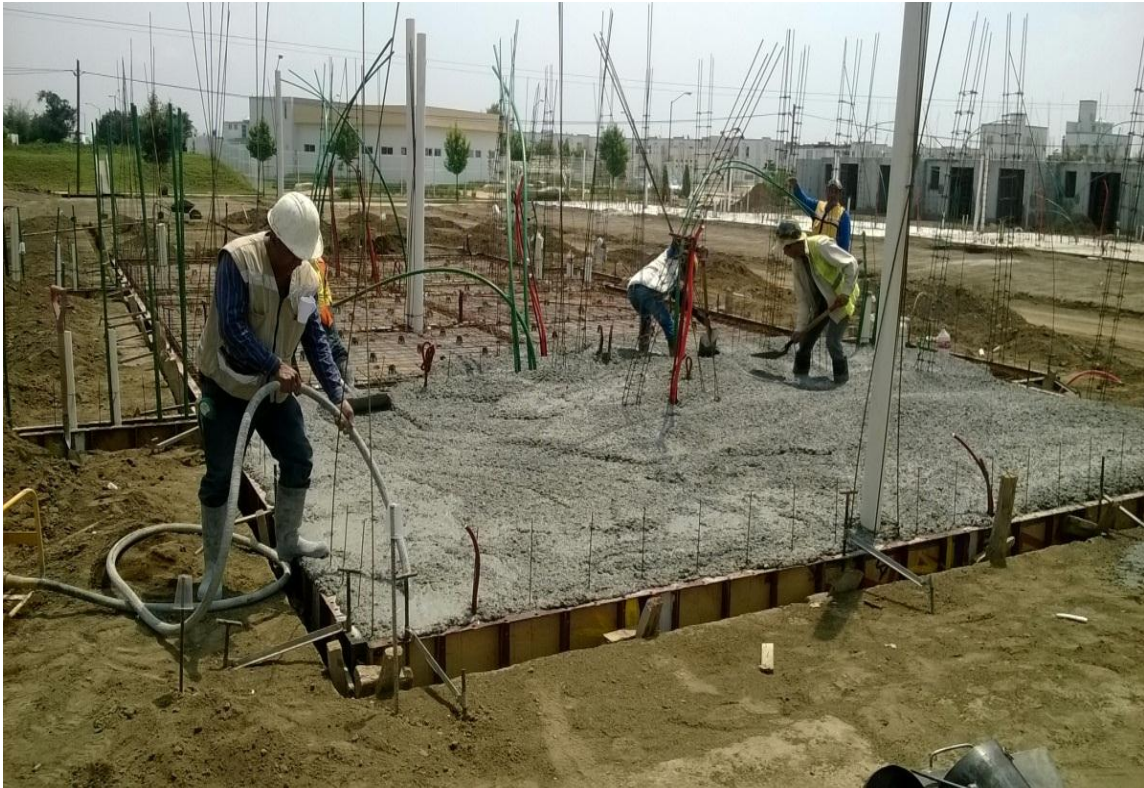
Fuente: propia, proceso de colado y vibrado de cimentación, Huejotzingo, Puebla consorcio ARA ATV
