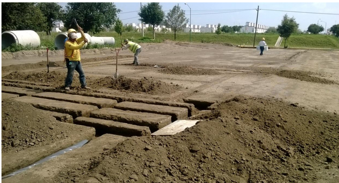
Fuente: propia, excavación de cepas, en Huejotzingo Puebla consorcio ARA ATV
