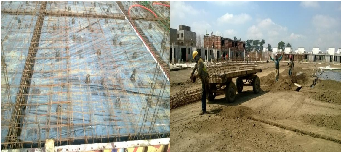
Fuente: propia, acarreo de acero con la plataforma al tramo e instalación de estructura, consorcio habitacional ATV
