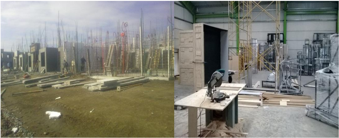
Fuente: Cimbra en Huejotzingo, Puebla y almacén de herramienta y material para museo Barroco en Puebla A.T.V
