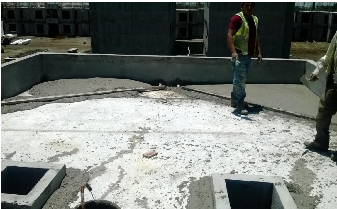
Fuente: propia, elaboración de los entortados, chaflanes con regla y reventón, en azotea Huejotzingo Puebla ATV
