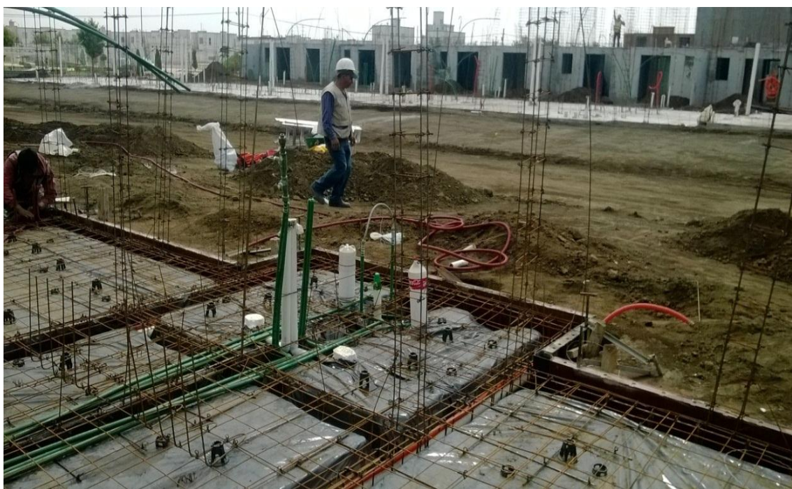
Fuente: propia, cimentación lista para el colado, Huejotzingo Puebla, consorcio ARA ATV
