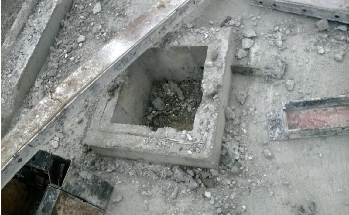
Fuente: propia, cuida que el acero no se vea, checa cuando estés colando, Huejotzingo Puebla, ATV
