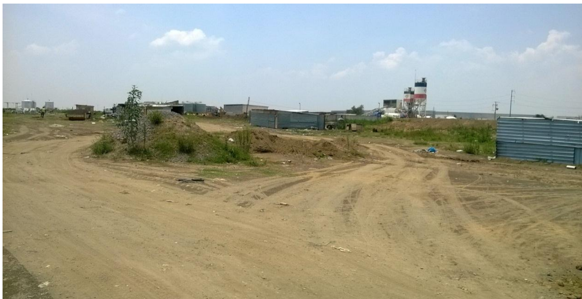
Fuente: propia, área para las bodegas de los contratistas y comedor, Huejotzingo Puebla, consorcio ARA ATV
