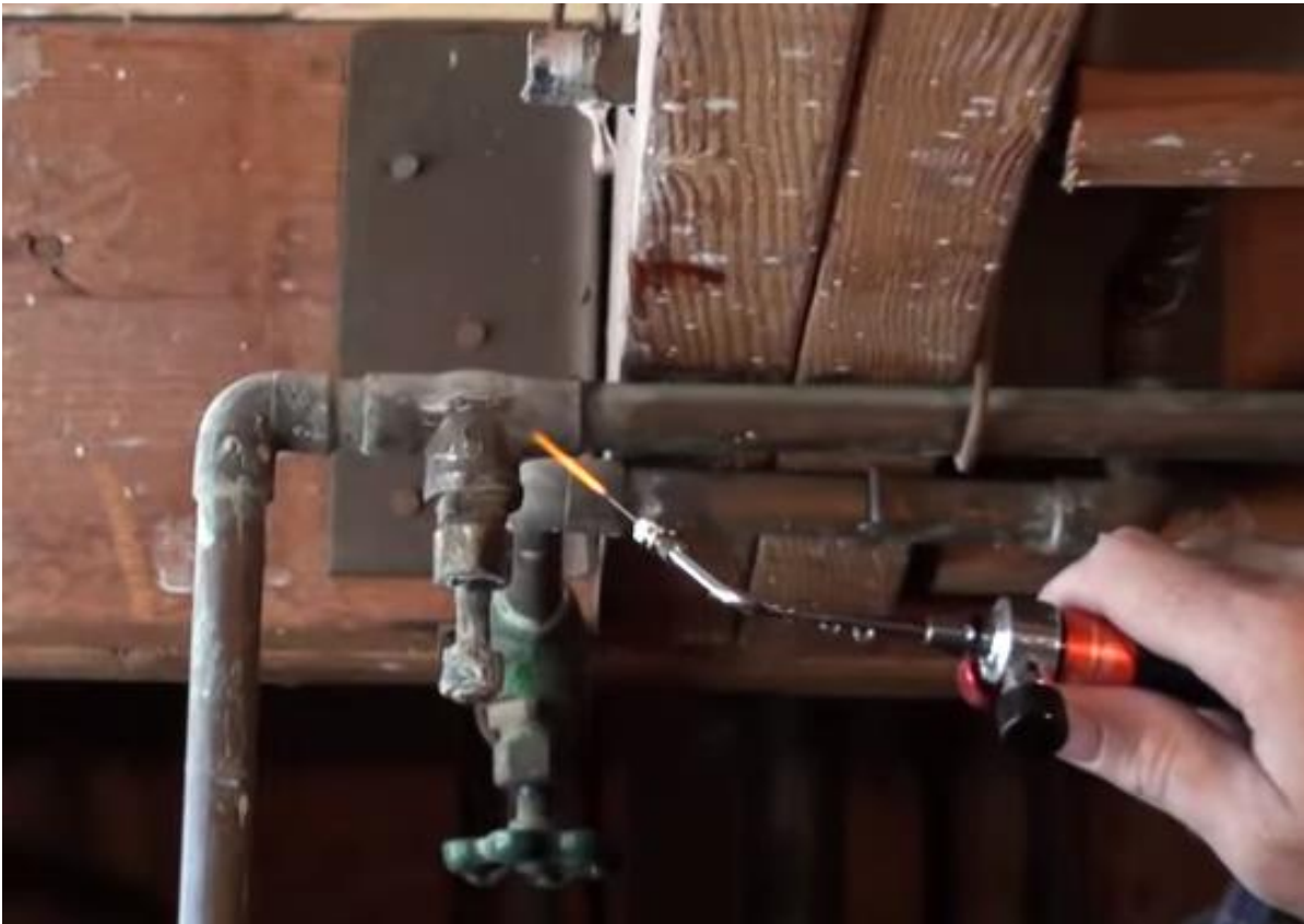
Foto#15 Soldar tuberías de cobre
