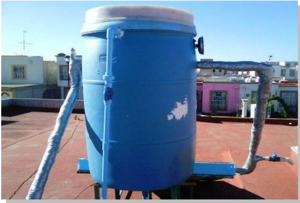
Fig.62.- ANGELES – 2010 - Instalación del Termo tanque con material reciclable en la azotea.
