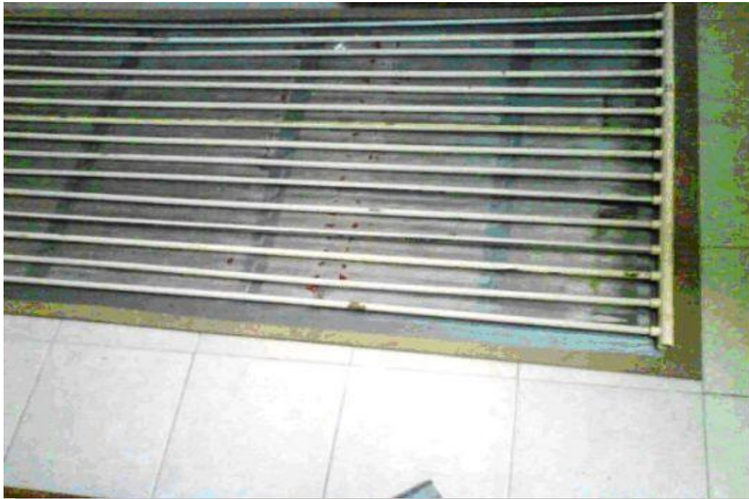
Fig.50.- ANGELES – 2010 - Una vez colocados los tramos de lámina hay que montar el radiador de tubos.
