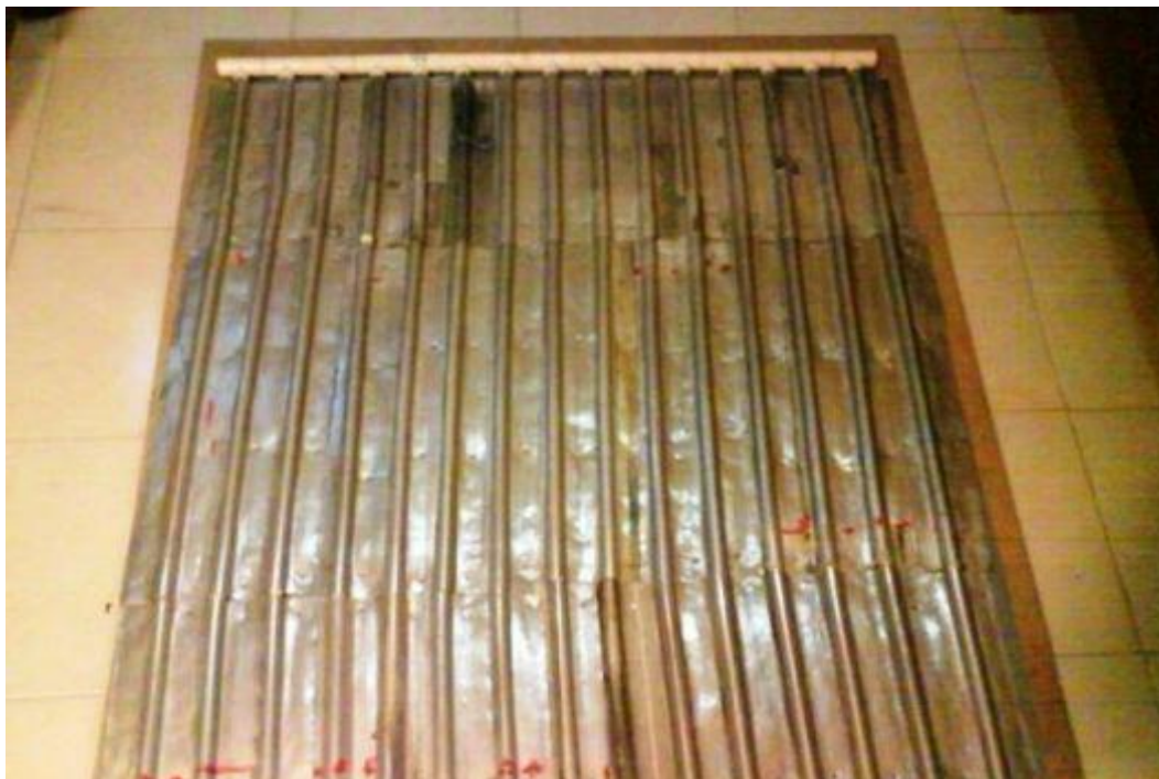
Fig.51.- ANGELES – 2010 - Ya que está colocado el serpentín hay que montar la otra parte de las láminas metálicas sobre el radiador, estas fueron dobladas previamente para darle la forma del tubo.
