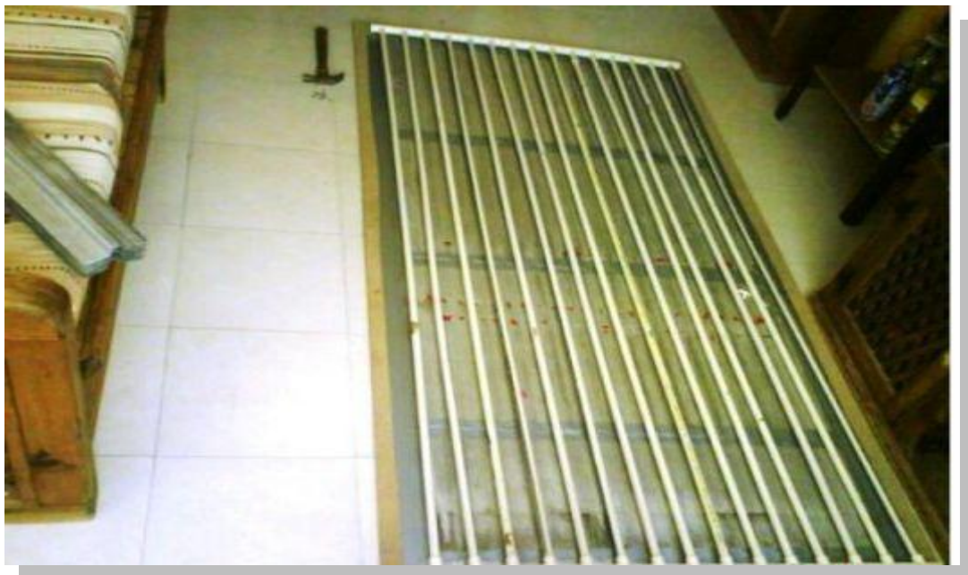
Fig.47.- ÁNGELES – 2010 - Armado del serpentín a base de tubos y conexiones cpvc.
