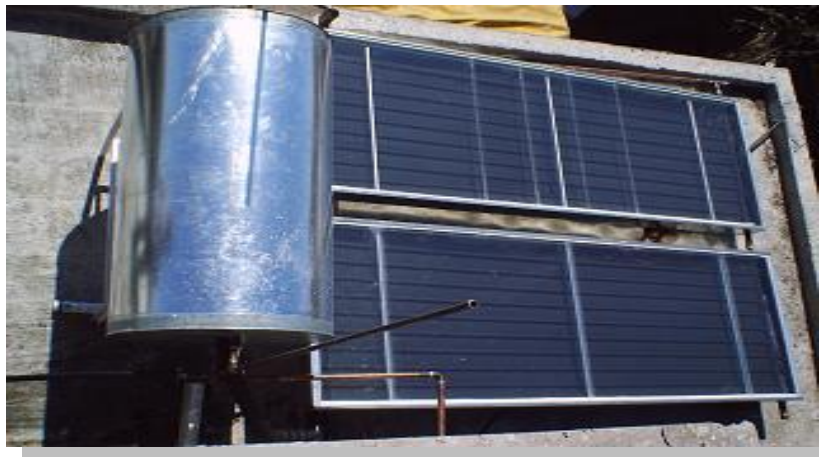
Fig.23.-SITIOSOLAR - 2009 - Instalación calentador solar para agua caliente doméstica en Tlaxcalantzingo.
