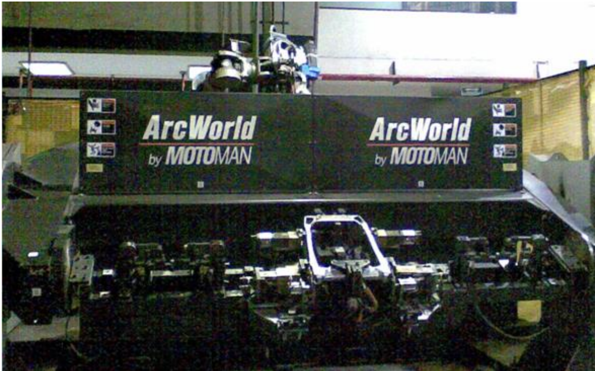
Figura 4.15: Sistema neumático utilizado en herramientas de soldeo de celdas dobles robotizadas para sujetar las piezas metálicas a soldar de un respaldo delantero lado derecho del modelo Bora A5.
