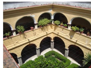
Ilus. 49 Vista al interior del patio del claustro
