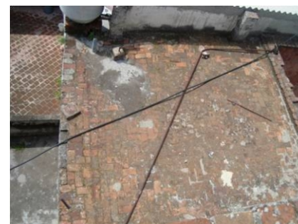
Ilus. 61 Cubierta de la zona de lavandería y cocina
