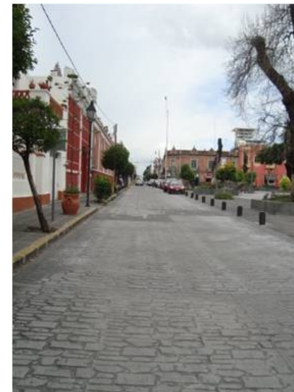
Ilus. 14 Pavimentación con concreto hidráulico
