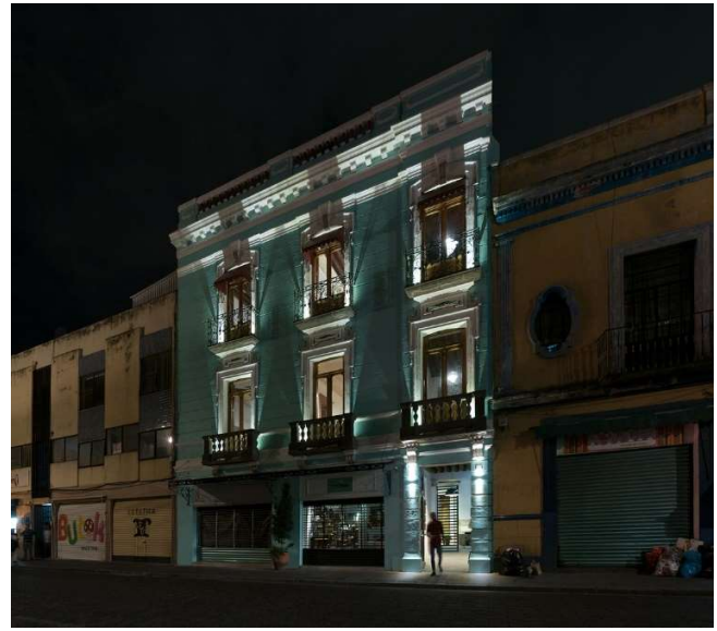
FIGURA 24.- Edificio de Noche.
