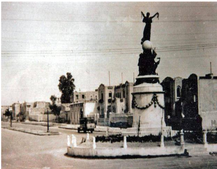
Imagen 25. Monumento a la Independencia 1931. Fuente: https://twitter.com/pueblaantigua/status/644324265496481792 . Consultada: Febrero 2011
