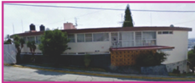
Foto 20. Casa Habitación Avenida Juárez N°1, entre Calle Huamantla y Tlahuapan Fuente: SLJ. 2012
