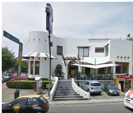
Foto 1. Transformación de paramentos. Autor: SLJ. Fecha: 2011.
