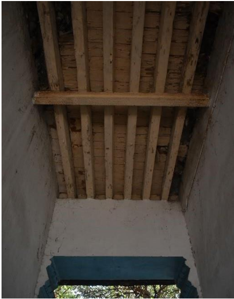
Detalle de las vigas en el pórtico de acceso (imagen propia)
