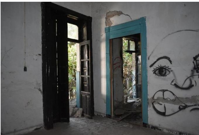
Detalle del interior de una habitación en el que se aprecias las puertas que conectan los espacios entre si y con el patio central (imagen propia)
