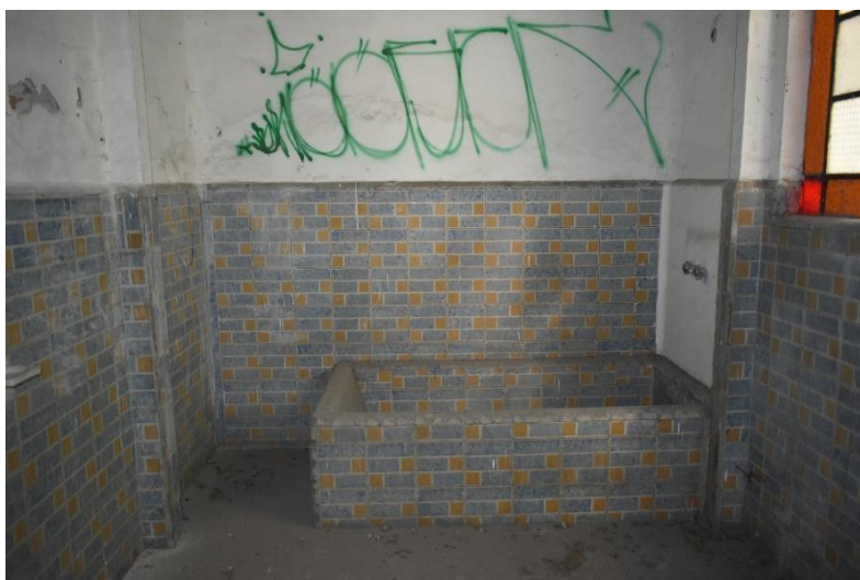
Imagen del baño existente (imagen propia)
