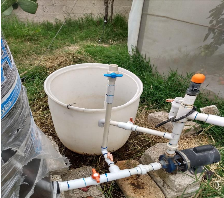
Figura 8. Instalación de sistema de riego para el tratamiento dos y tres.
