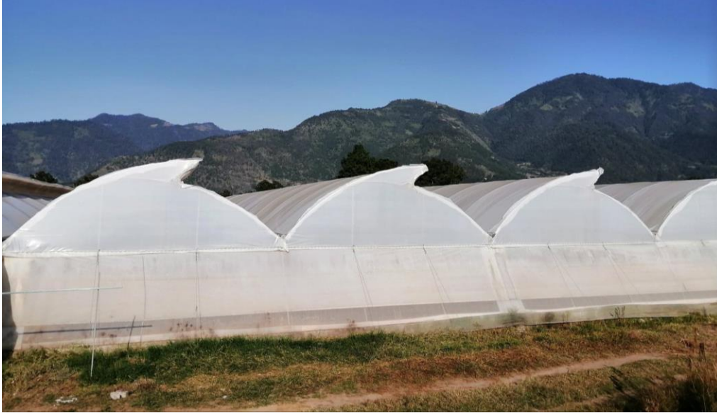
Figura 19. Vista frontal de la estructura de una multinave, Invernadero tipo cenital en la localidad de Puente Seco, Tetela de Ocampo.
