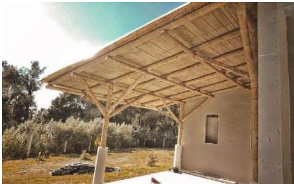
[Foto 44] Columna con ensamblajes de boca de pescado para sostener un techo verde en la entrada de la casa del Popocatepetl. Dicma Trade, 2016.
