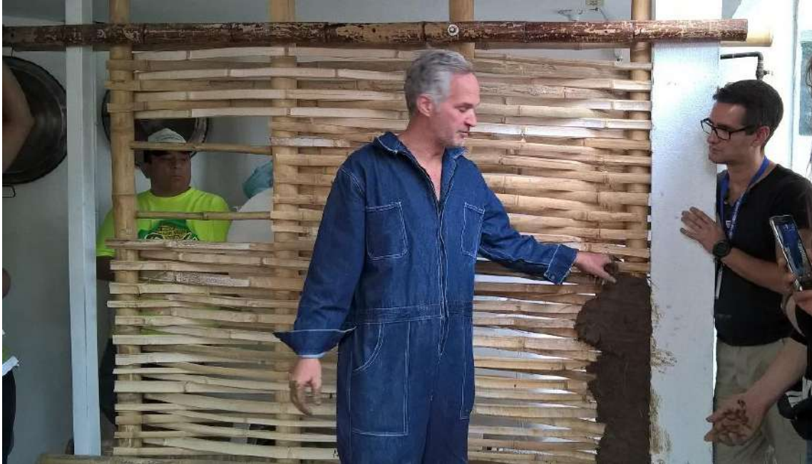
[Foto 38] Colocación de adobe en el muro de bahareque. Tlahuetl, Y. 2016.
