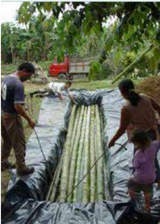
Zanja para inmersión
