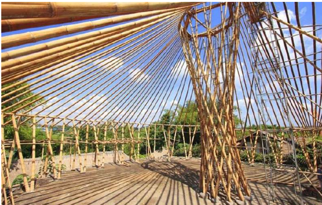
[Foto 55] Torres hiperbólicas, diseñado y construido por Jorg Stamm. “Siete conceptos para hacer un puente de bambú.” (P. 25) Stamm, J. 2009. Tailandia.
