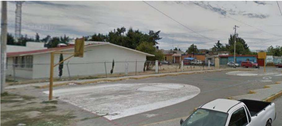
[Foto 72] Canchas del centro de salud, se aprecia la falta de equipamiento y bardas, así como los cajones de estacionamiento forjados en el pavimento. Foto obtenida de: Google Maps. 2016.
