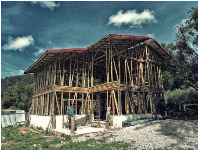
[Foto 61] Casa Popocatepetl, Puebla construida a las faldas del volcán tiene aproximadamente 2,000 metros lineales de bambú, en la foto aún no ha sido recubiertas de paneles prefabricados para su protección. Staff Dicma Trade. Mayo 2015. https://www.facebook.com/pg/DICMA-TRADE-939140182780390/photos/?tab=album&album_id=971784446182630&ref=page_internal
