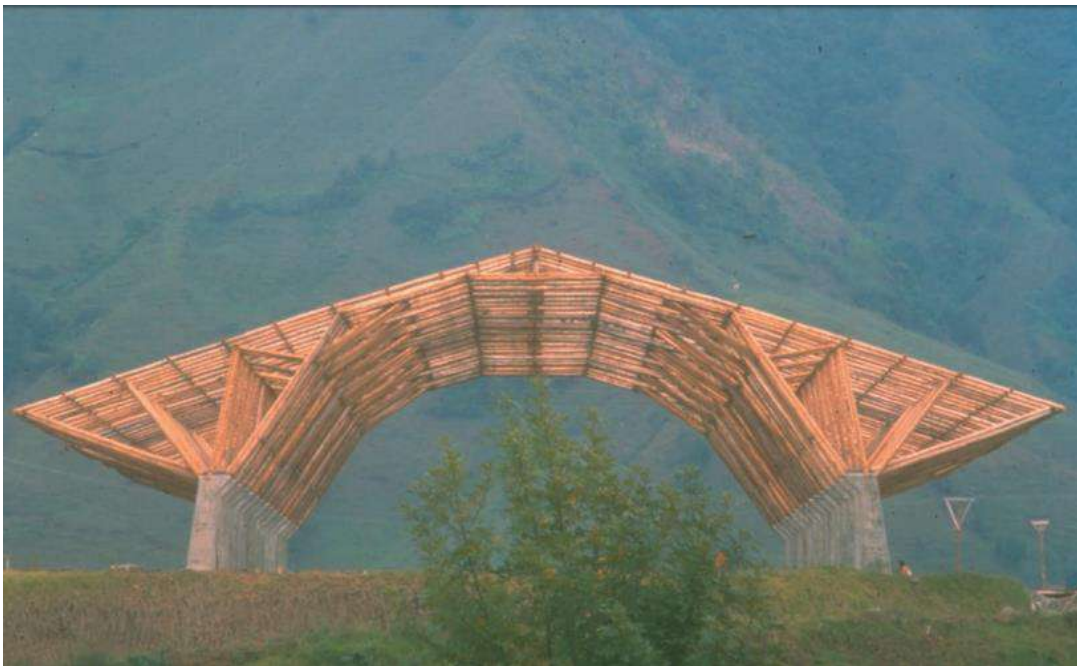
[Foto 47] Estructura mixta de columnas y cimentación de hormigón y estructura de guadua. “La importancia de la guadua en la obra de Simón Vélez” Por Salas, E. 2006. Boletín de arquitectura n. 241. P.15.
