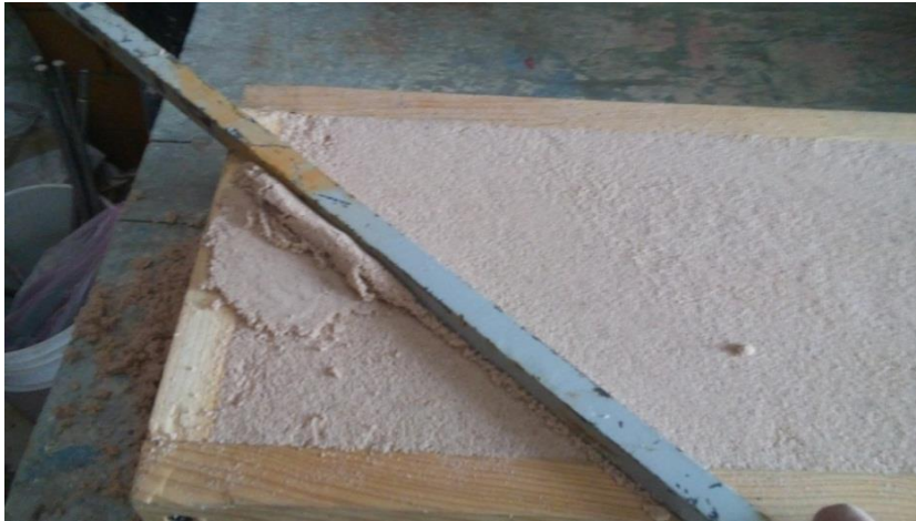
Figura 41. Quitando el exceso de arena.
