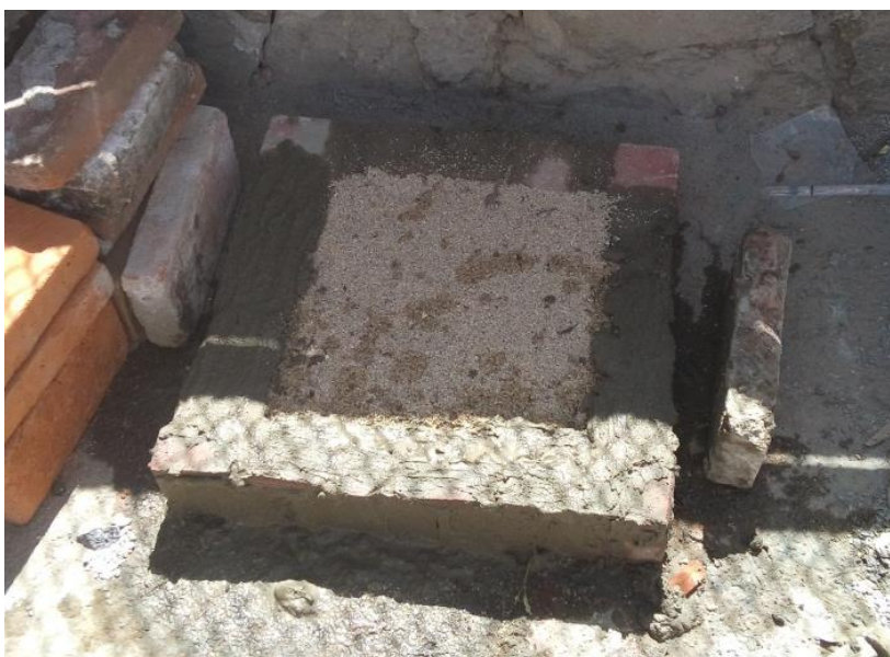
Figura 28 Base de horno con relleno de arena.
