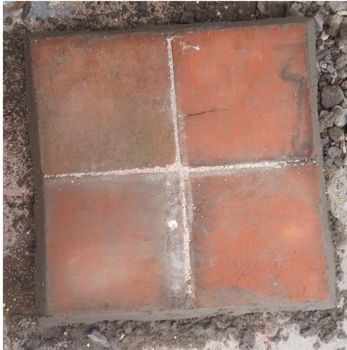
Figura 29. Base de horno terminada.
