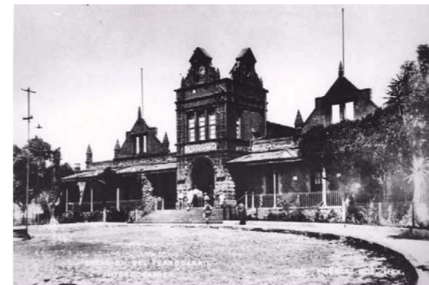
Fachada de la estación del Ferrocarril Interoceánico en la ciudad de Puebla. Fuente: http://1.bp.blogspot.com/-xo3vxrqRzd0/UA4PE9_eP7I/AAAAAAAAACQ/aFKrSWjWMoc/s1600/ferrocarrilinteroceanic.jpg
