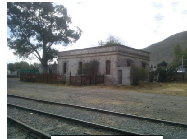
Casa del maestro mecánico. Fuente: Francisco Ruiz Herrera
