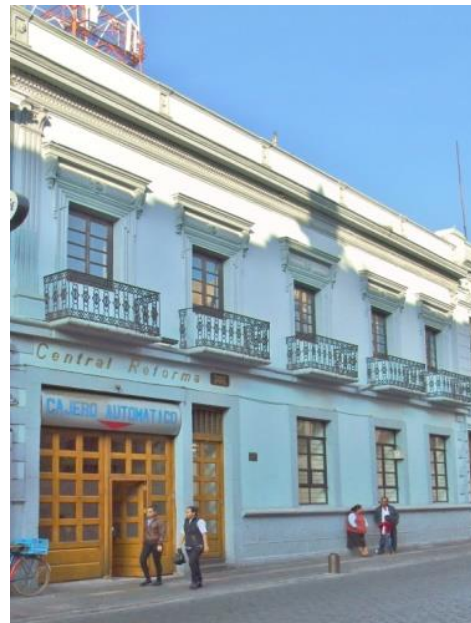
Ilustración 152. Casa de la acera sur de la calle de Cholula #11. (Reconstrucción virtual y fotografía KGM)
