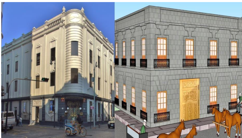
Ilustración 182. Casa de la acera sur de la calle del Hospicio #½. (Reconstrucción virtual y fotografía KGM)
