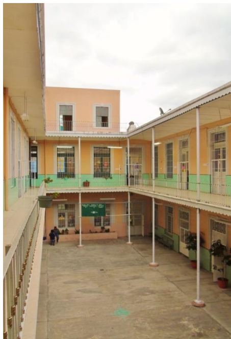
Ilustración 95. Vista actual de uno de los tres patios con los que cuenta el edificio del Grupo Escolar. (Fotografía KGM)
