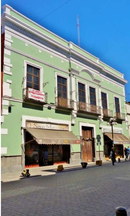
Ilustración 199. Casa de la acera norte de la calle de Guadalupe #10. (Reconstrucción virtual y fotografía KGM)
