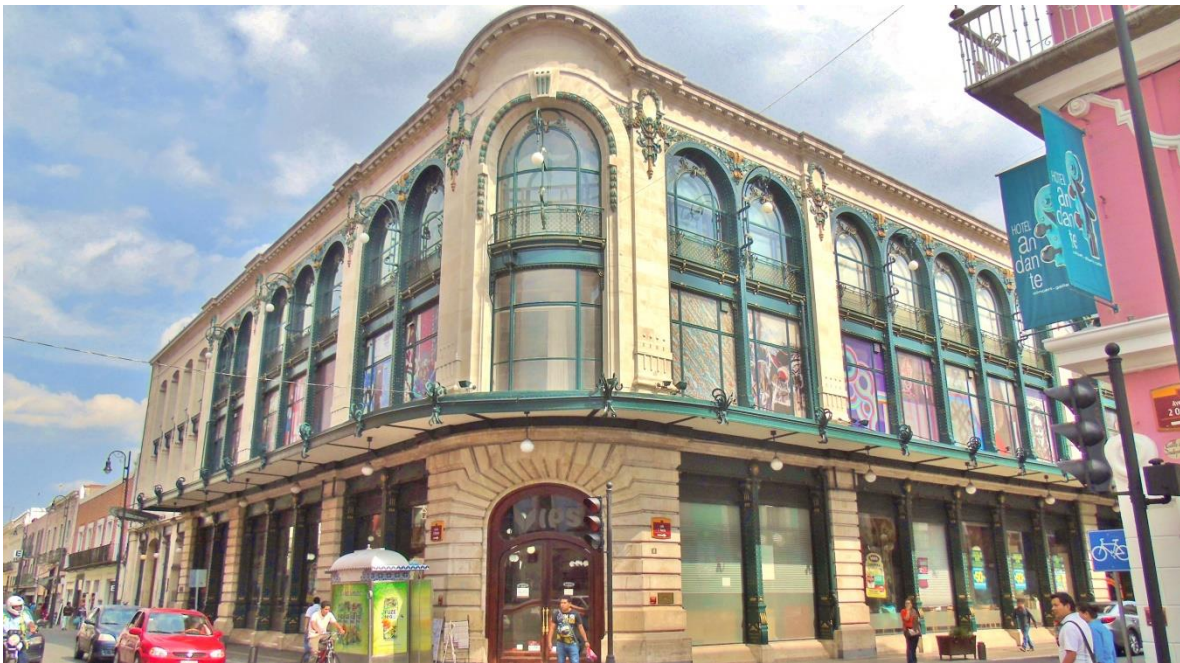
Ilustración 227 Vista actual del edificio que ocuparon los almacenes de la Ciudad de México. (Fotografía KGM)
