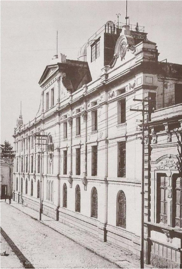
Ilustración 106. Fachada oriente del colegio del estado, en la parte superior central se instaló el observatorio de la Universidad. (Colección KGM)
