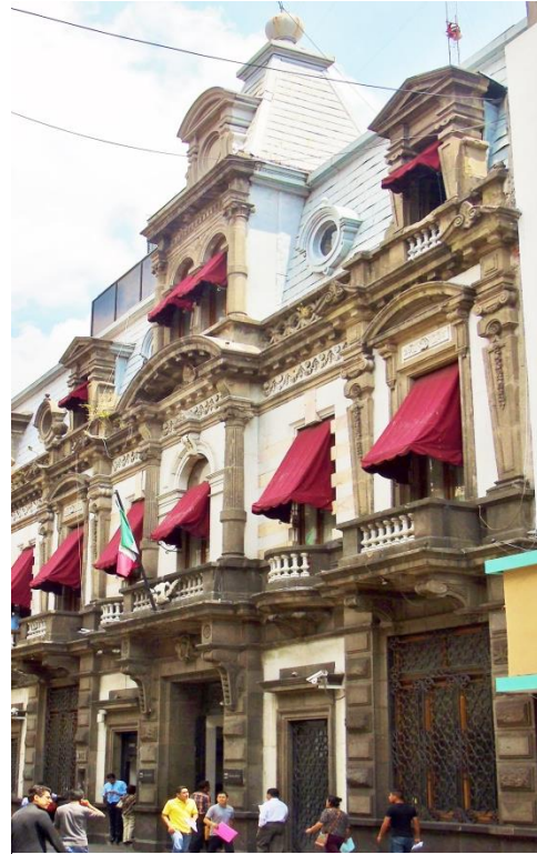
Ilustración 129. Casa de la acera sur de la calle de Zaragoza #7. (Fotografía KGM)
