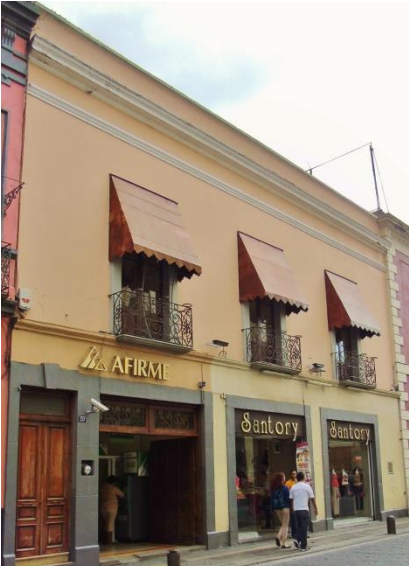
Ilustración 155. Casa de la acera sur de la calle de Cholula #17. (Reconstrucción virtual y fotografía KGM)
