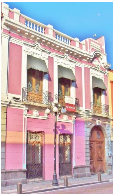
Ilustración 206. Casa de la acera sur de la calle de Guadalupe #5. (Fotografía KGM)
