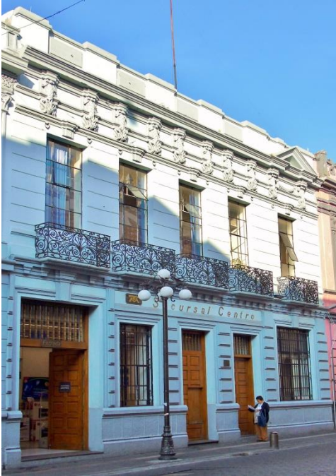
Ilustración 153. Casa de la acera sur de la calle de Cholula #15. (Reconstrucción virtual y fotografía KGM)
