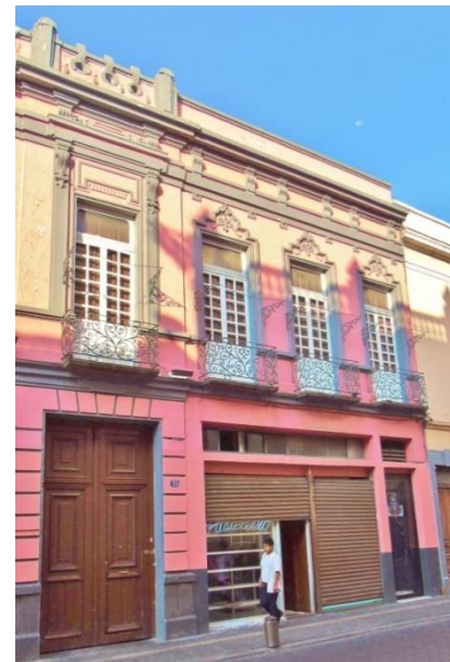
Ilustración 154. Casa de la acera sur de la calle de Cholula #15. (Reconstrucción virtual y fotografía KGM)
