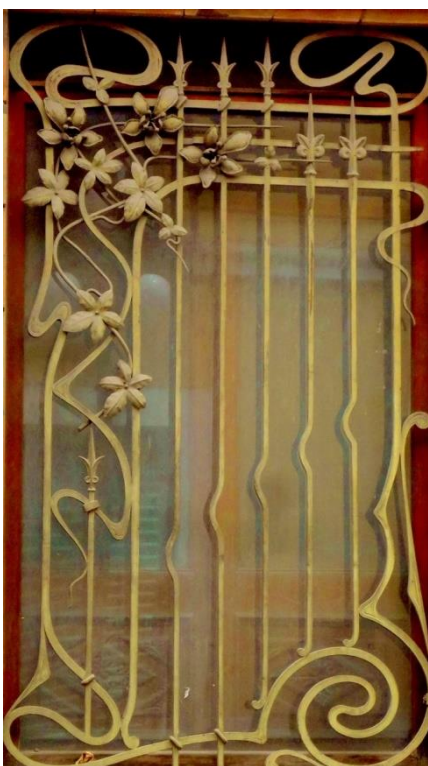
Ilustración 174. Detalle de herrería estilo art nouveau de la casa de la acera sur de la calle de Miradores #5. (Fotografía
