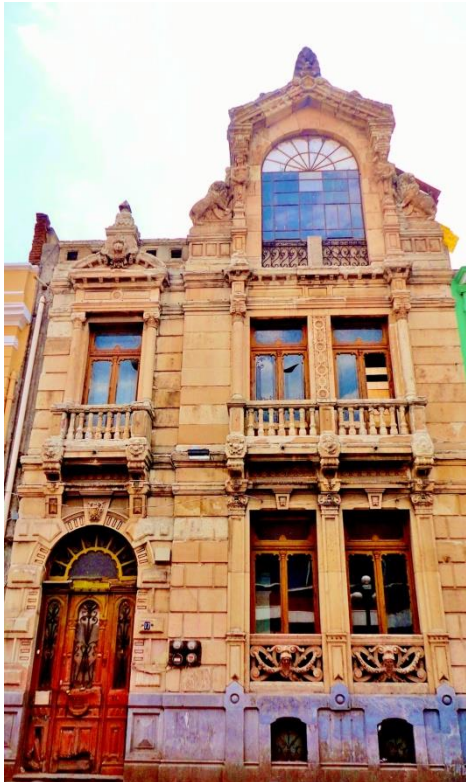
Ilustración 212. Casa de la acera sur de la calle de Guadalupe #15. (Fotografía KGM)
