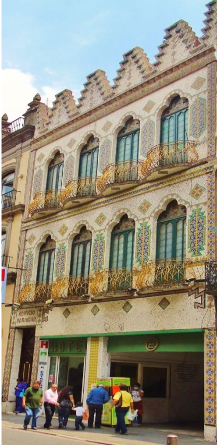
Ilustración 134. Edificio Bamar. (Fotografía KGM)
