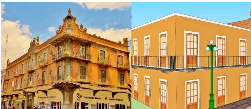
Ilustración 202. Casa de la acera norte de la calle de Guadalupe #16. (Reconstrucción virtual y fotografía KGM)
