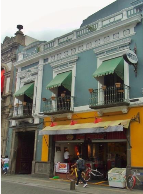
Ilustración 151. Casa de la acera sur de la calle de Cholula #9. (Reconstrucción virtual y fotografía KGM)
