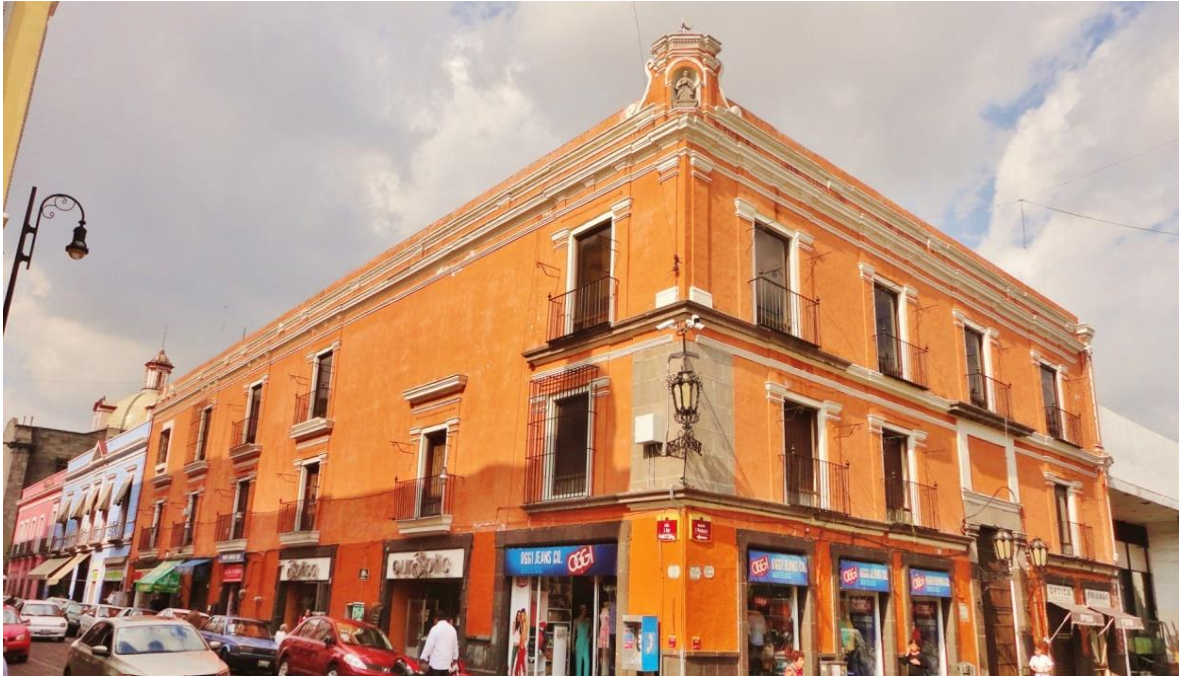
Ilustración 5. Casa en la esquina de la calle de las Peñas (3 sur) y la del Correo viejo (5 poniente) que posee tres niveles de los cuales el segundo es mas bajo y se le otorga la denominacion de entresuelo. (Fotografia KGM)
