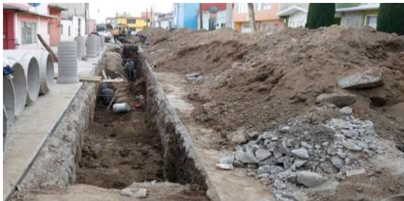
Colocación de drenaje publico
