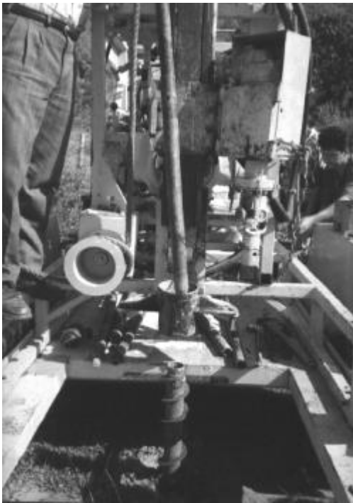
Figura 27. Equipo de perforación con tubo partido.
