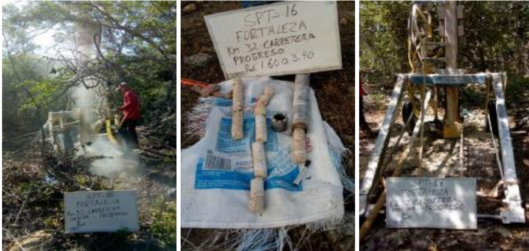
Sondeo 16 y 17: Ejecución, evaluación de muestras e instalación.
