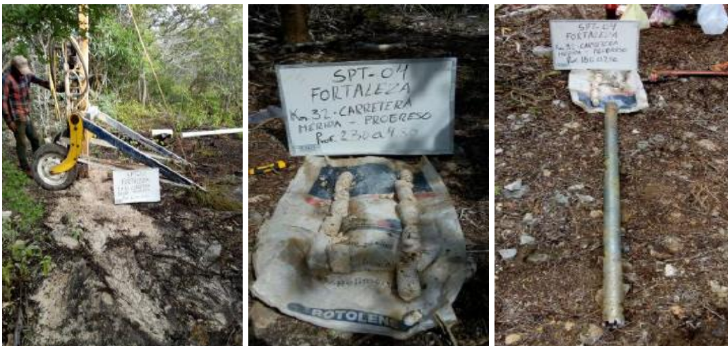
Sondeo 3 y 4: Ejecución, clasificación de muestras y extracción de muestras del tubo partido.
