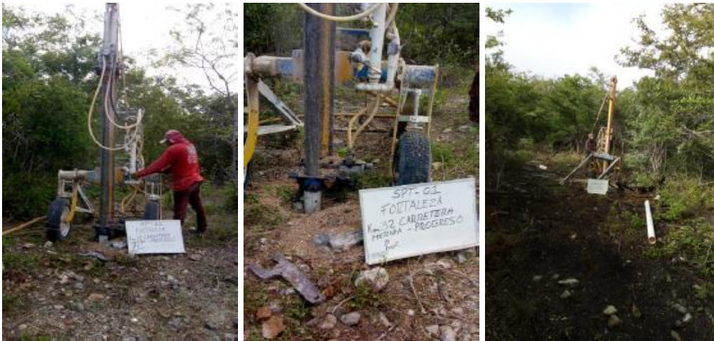
Sondeo 1 y 2: Instalación y ejecución.
