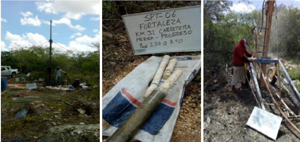
Sondeo 5 y 6: Instalación, clasificación de muestras y ejecución.
