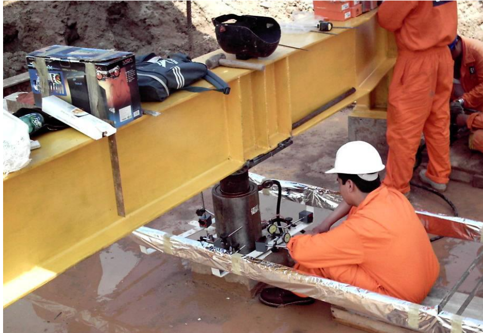
Figura 2.14. Ejecución de la prueba de carga de placa (Imagen obtenida de la web).
