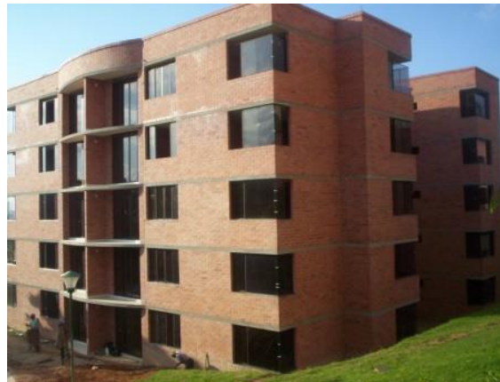
Figura I.5 Multifamiliar de mampostería estructural, fuente: Saveraconstruccion.com
