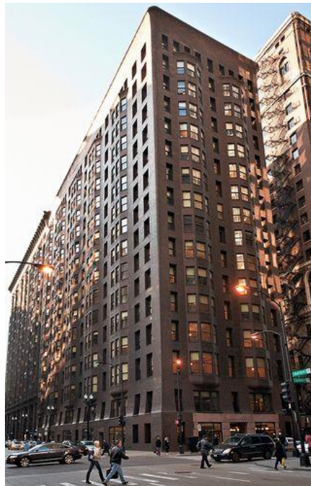
Figura I.3 Edificio Monadnokc en Chicago construido con muros portantes de mampostería. Fuente: Pinterest.com
