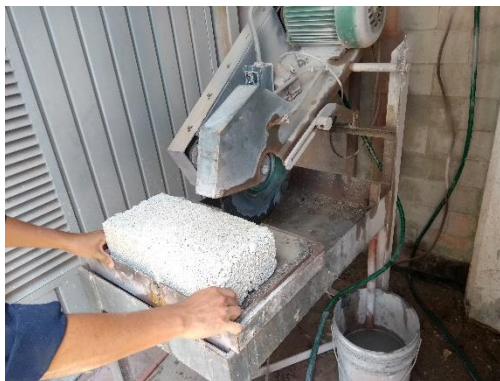
Figura II.14 corte de pieza con equipo y protección adecuado
