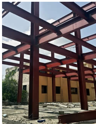
ILUSTRACIÓN 46 ESTRUCTURA DE ACERO
