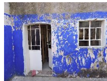
IMAGEN 32.1 Terraza 2 Fuente: Visita 09 de Noviembre 2017
