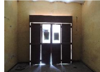
IMAGEN 15.1 Acceso Principal a Restaurante Fuente: Visita 09 de Noviembre 2017
