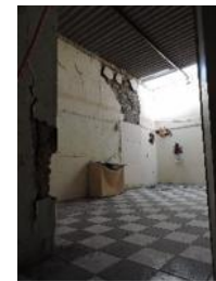
IMAGEN 31.2 Terraza 1 Fuente: Visita 09 de Noviembre 2017
