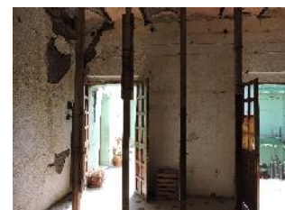
IMAGEN 23.2 Accesos desde el Pasillo Fuente: Visita 09 de Noviembre 2017
