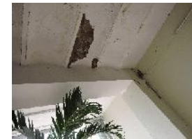
IMAGEN 25.1 Viga y Columna Fuente: Visita 09 de Noviembre 2017
