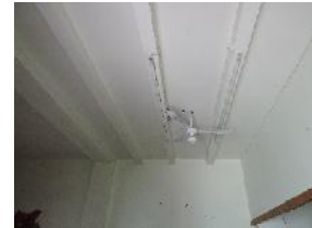
IMAGEN 22.1 Traves en Losa Maciza Fuente: Visita 09 de Noviembre 2017
