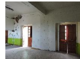
IMAGEN 21.3 Acceso desde el Pasillo Fuente: Visita 09 de Noviembre 2017
