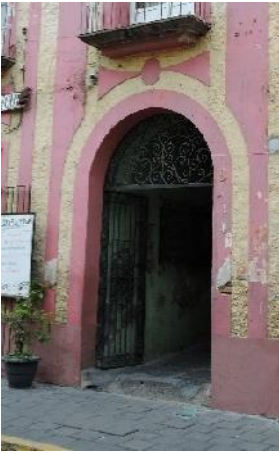
IMAGEN 1.1 Acceso Principal Fuente: Visita 15 de Septiembre 2017
