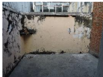
IMAGEN 32.1 Terraza 2 Fuente: Visita 09 de Noviembre 2017
