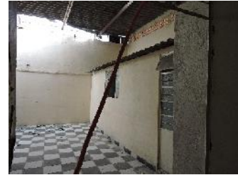
IMAGEN 31.1 Terraza 1 Fuente: Visita 09 de Noviembre 2017
