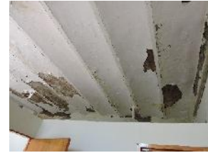
IMAGEN 25.2 Losa Catalana Fuente: Visita 09 de Noviembre 2017
