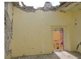
IMAGEN 20.1 Muro de Fachada Fuente: Visita 09 de Noviembre 2017
