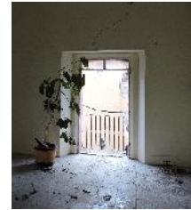
IMAGEN 19.2 Balcón Fuente: Visita 09 de Noviembre 2017
