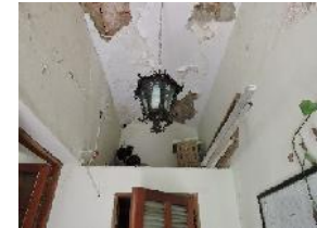
IMAGEN 25.3 Anexo de Sanitario Fuente: Visita 09 de Noviembre 2017
