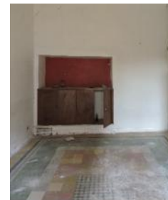
IMAGEN 29.2 Acceso Bloqueado Fuente: Visita 09 de Noviembre 2017
