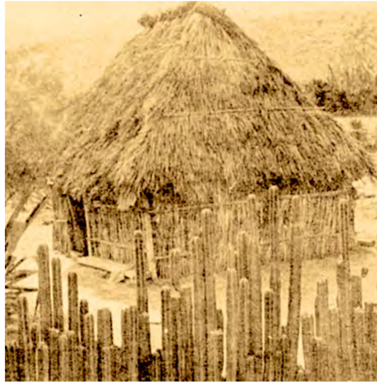
Vivienda de Zaachila, Oaxaca. Los muros de cactus de las viviendas mixtecas que delimitan simbólicamente el espacio protegido.
