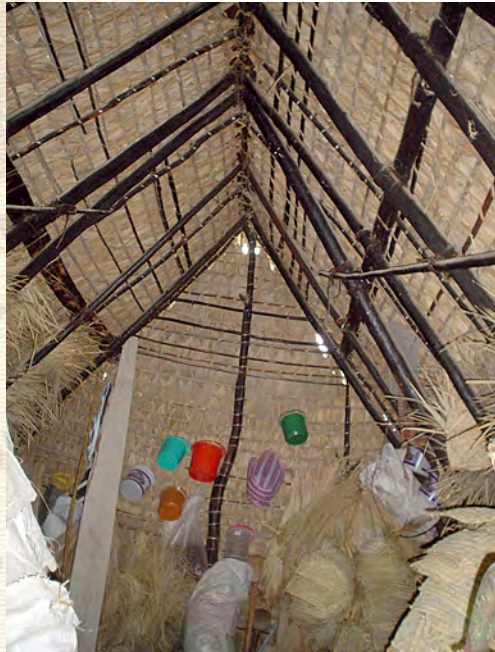
En esta imagen nótese el color de la estructura esto se debe a que esta, pertenece a lo que en el pasado fue una cocina y ahora con la paja renovada (casi blanca) hacen un contraste.
