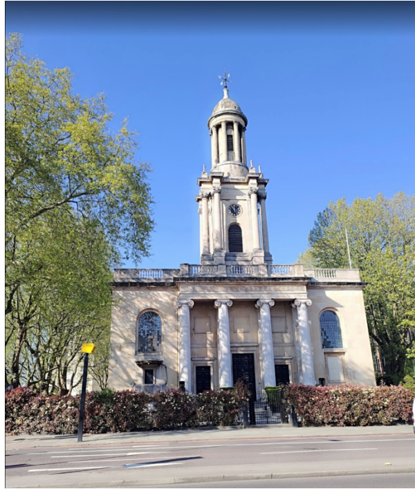
Imagen 7 Fachada de la Iglesia de la Santísima Trinidad, recuperada de: https://www.google.com.mx/maps/
