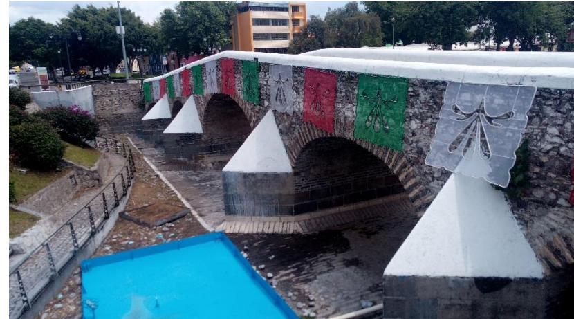
Fotografías 2.24 Puente de Ovando Fuente: Archivo propio
