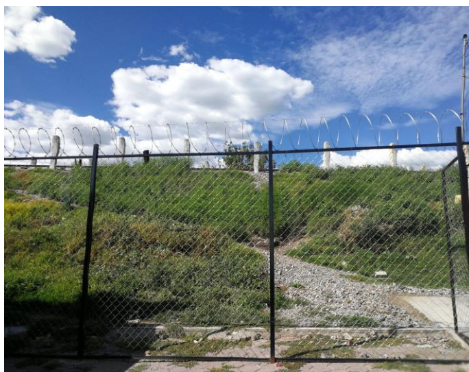
Imagen 5: Valla que divide el acceso al albergue de la privada “colfer”
