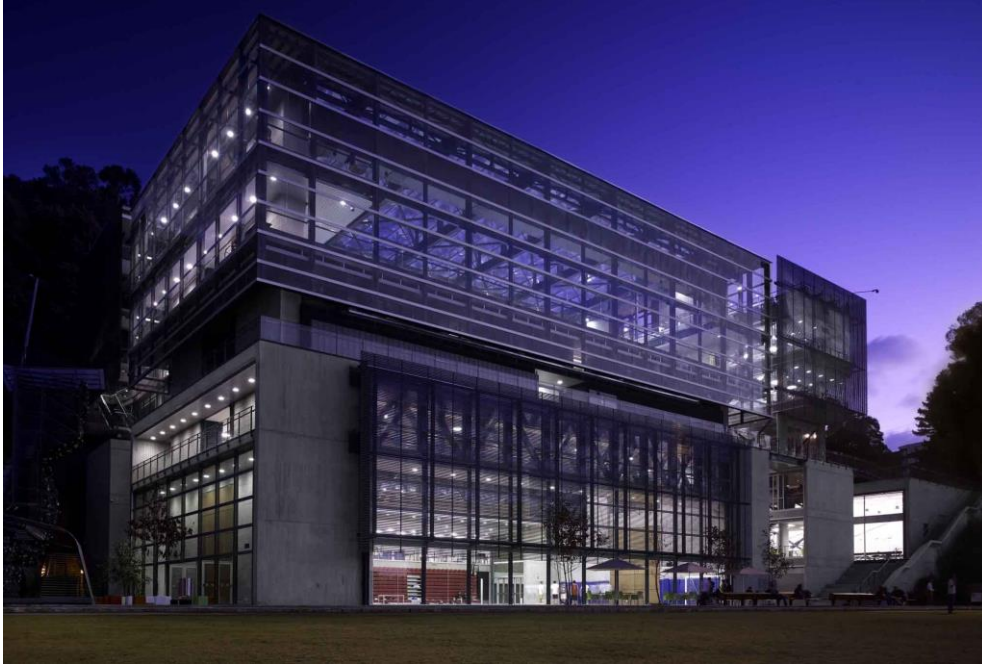
Figura 31. Vista exterior de edificio deportivo, (fuente: https://www.arquitecturapanamericana.com/centro-deportivo-universidad-de-los-andes/nggallery/page/1 ).
