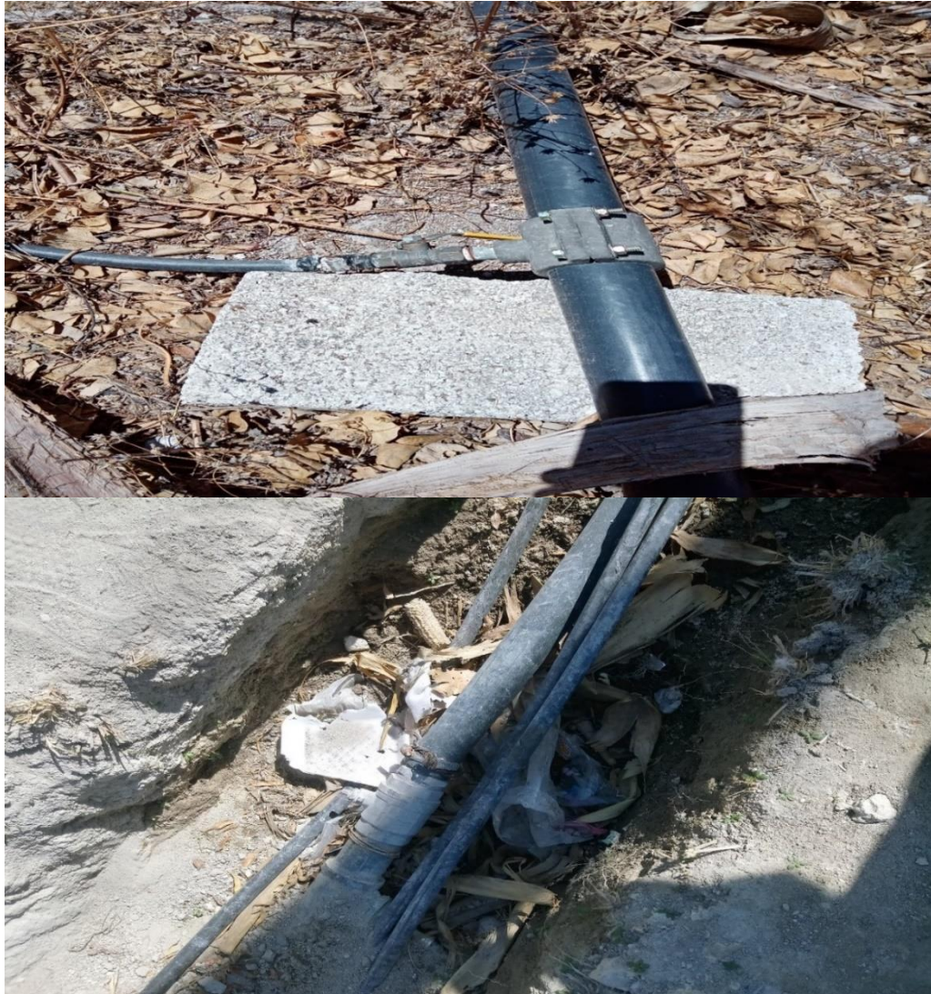
Figura 9. Tubería identificada en la red de distribución.
