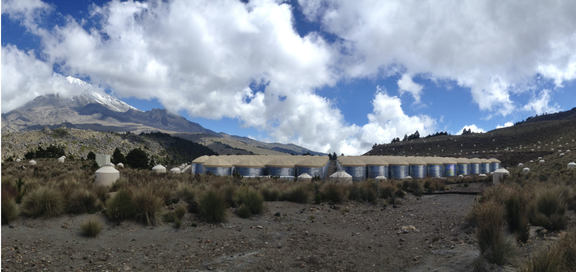
Figura 2.1: Fotografía de la vista lateral del Observatorio HAWC.
