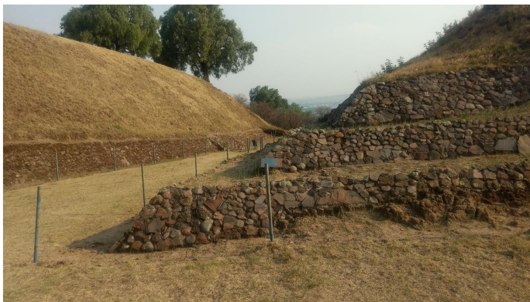
Talud en Los Cerritos de San Cristóbal Tepatlaxco
