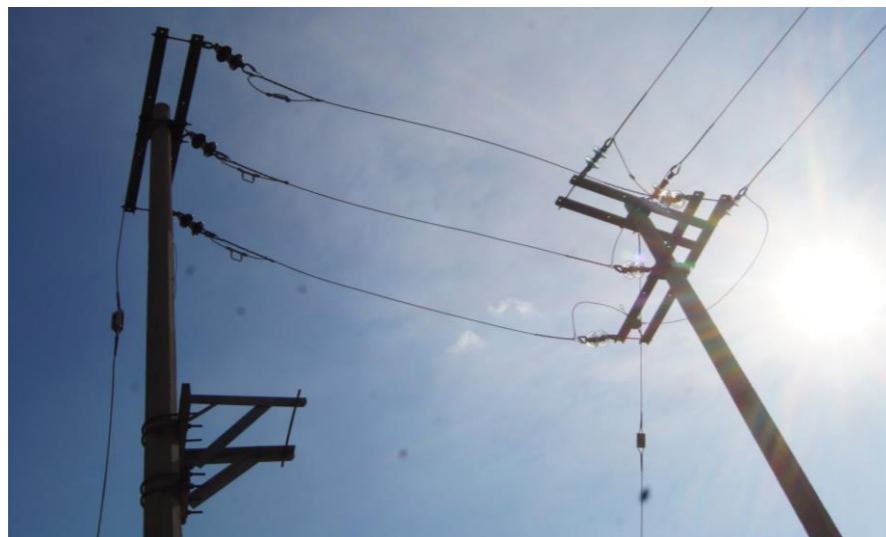
Figura 27. Postes Eléctricos cercanos del predio. Foto tomada por: De la Cruz Palacios, Jesús Emmanuel (2018).
