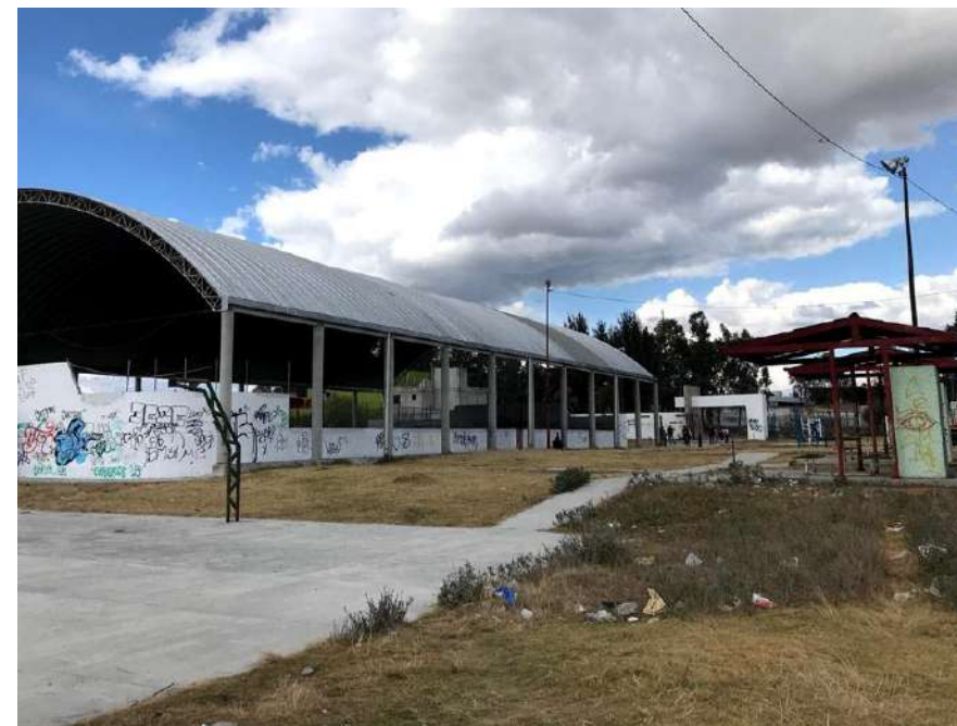
Imagen No. 2, Ramírez G, (2020), Estado actual de la unidad deportiva de Tlaltepango. San Pablo del Monte, Tlaxcala, Tomada el día 17 de enero 2020
