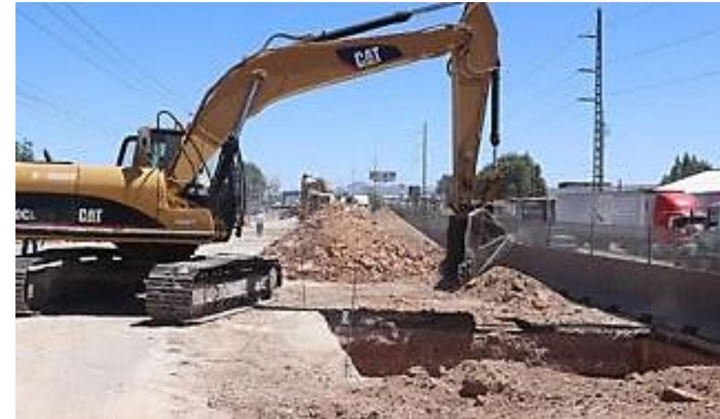
Ilustración 5.5: Excavación con maquinaria.
