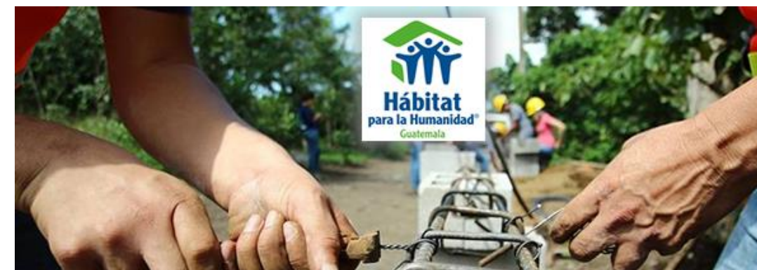
Ilustración 6.11: Trabajos de habilitación de acero - Fundación Hábitat para la humanidad
