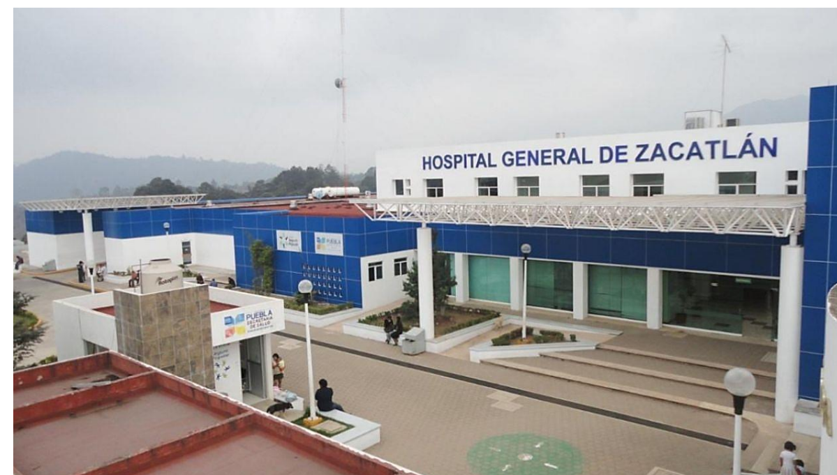
Ilustración 4.2: Hospital General de Zacatlán.
