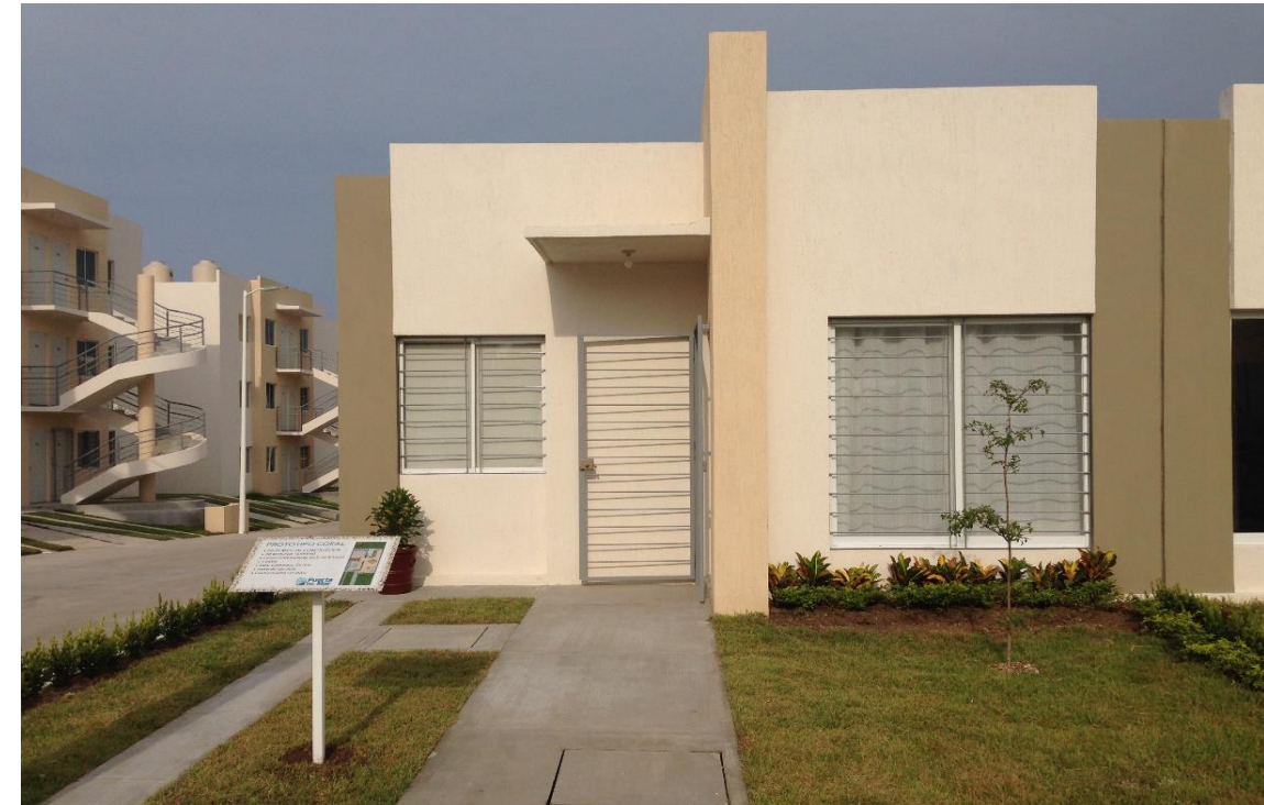
Ilustración 5.10: Vivienda con un solo nivel de construcción.
