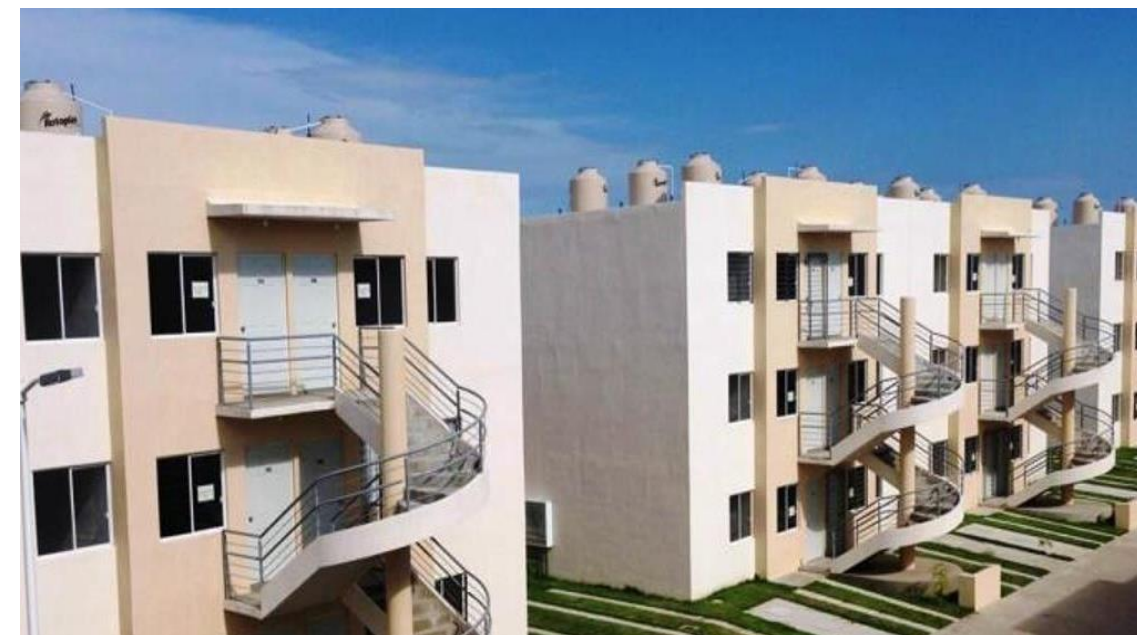
Ilustración 5.12: Edificio de departamentos.
