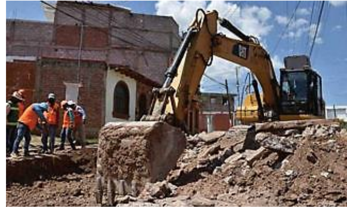
Ilustración 5.3: Ejecución y proceso de obra.
