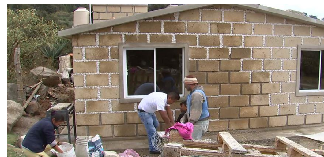
Ilustración 6.12: Colocación de acabados - Fundación vamos a dar
