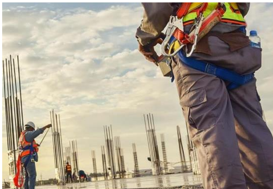
Ilustración 5.14: Ejecución del colado de losa.
