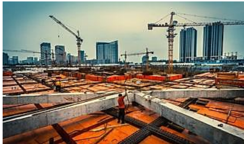
Ilustración 5.4: Ejecución y proceso de obra.
