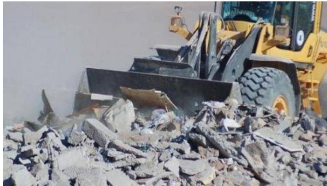
Ilustración 5.16: Retiro de escombros en obra.
