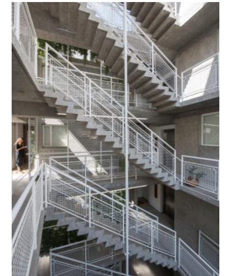
1.15) Escaleras de conexión a los departamentos de TOLSA61 (MOCAA, 2016). Arch Daily / https://www.archdaily.mx/mx/886259/tolsa-61-mocaa-arquitectos
