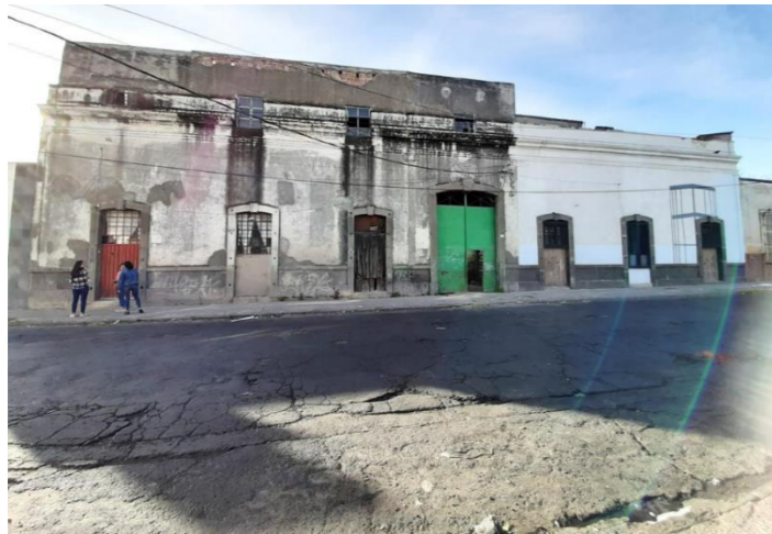
4.1.4) Estado actual de calle 7 norte
