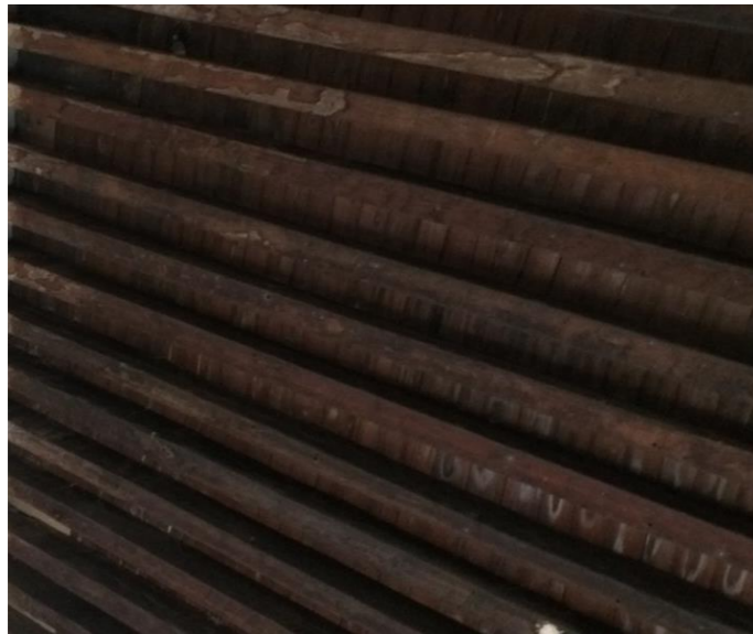
5.2.2.1) Losa de cubierta actual en la vecindad "El Pocito"
