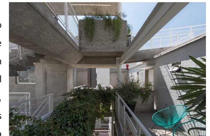
1.13) Diferentes vistas del patio central perteneciente a TOLSA61 (MOCAA, 2016). Arch Daily / https://www.archdaily.mx/mx/886259/tolsa-61-mocaa-arquitectos
