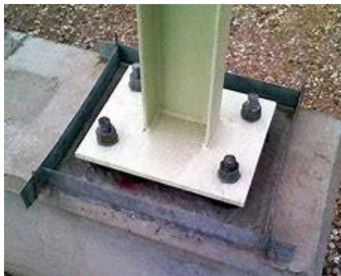
Figura 4.7 Anclaje de columna a cimentación
