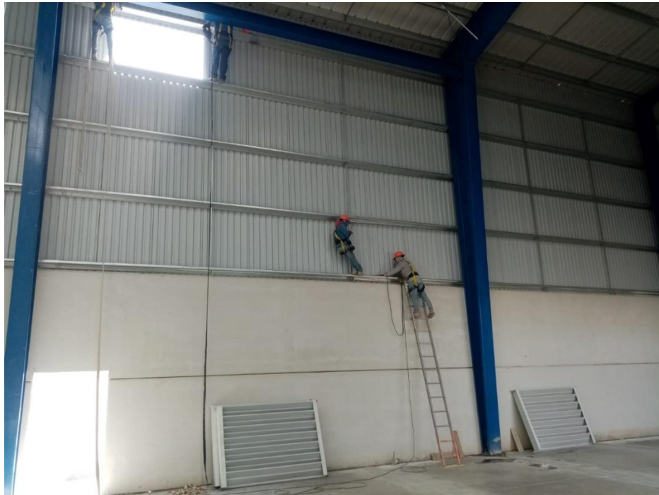
Figura 4.20 Muro perimetral de nave industrial Amozoc, Puebla
