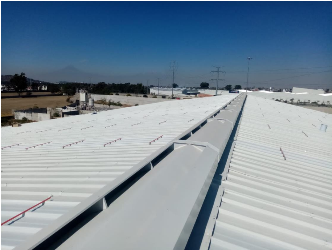
Figura 4.24 Cubierta de lámina a dos aguas
