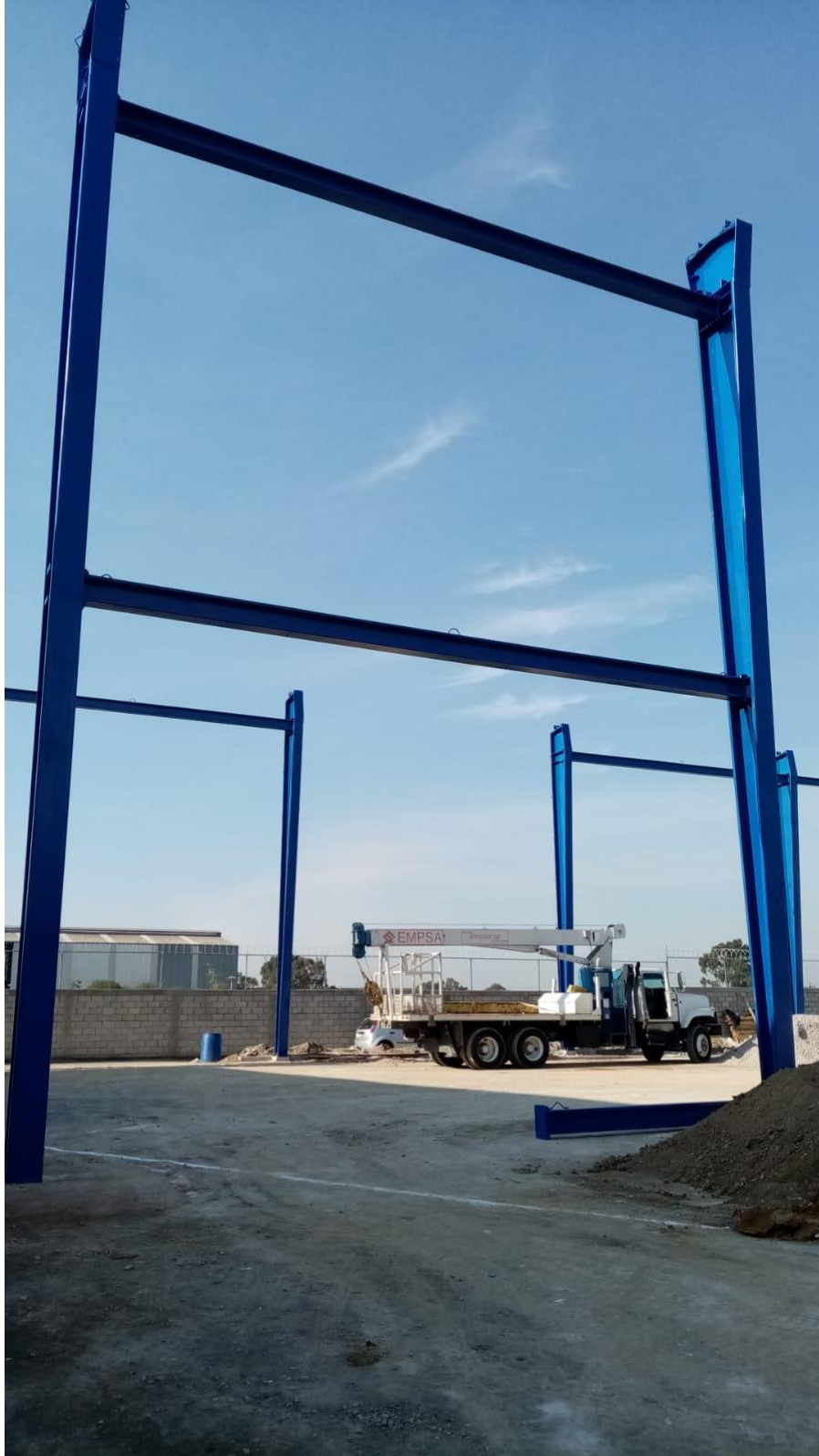
Figura 4.18 Estructura a base de marcos
