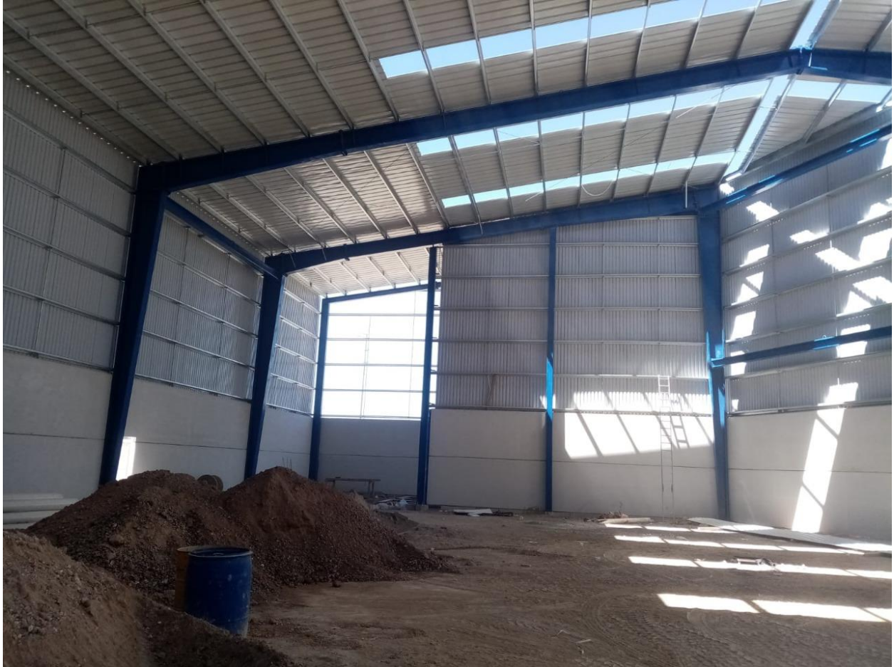
Figura 4.21 Muros perimetrales de nave industrial Amozoc, Puebla
