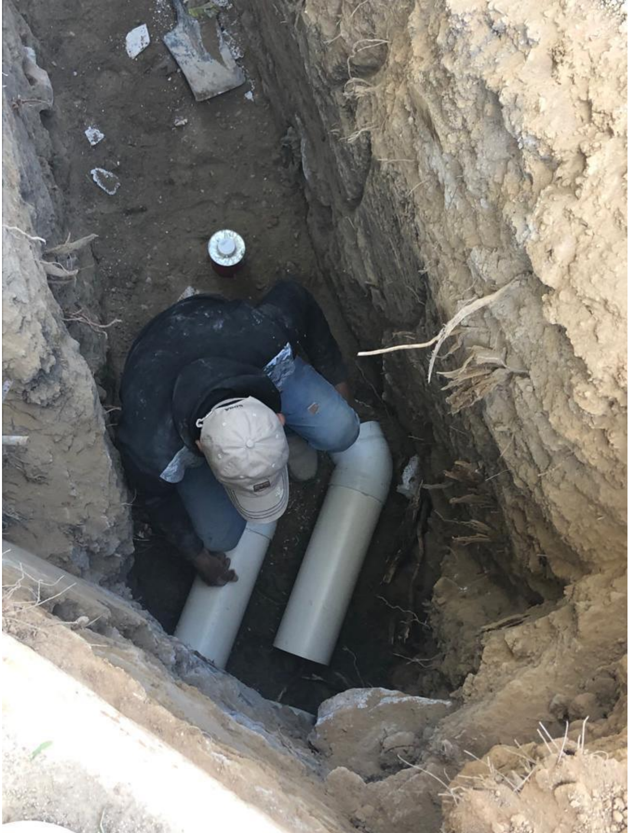
Figura 4.15 Instalación de tubos de drenaje
