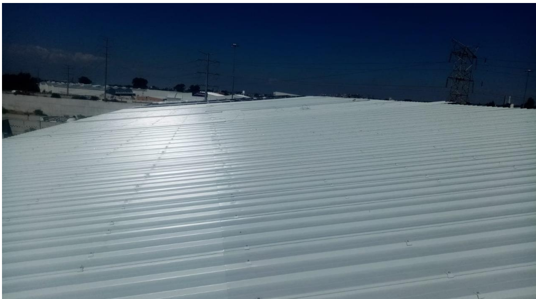
Figura 4.23 Cubierta de lámina
