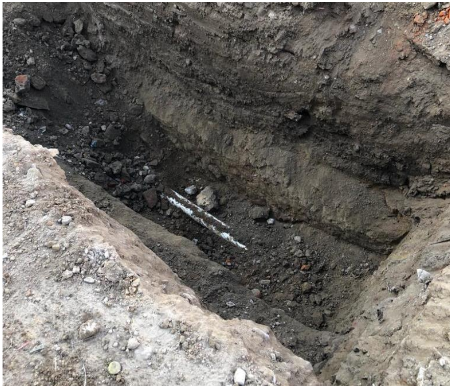
Figura 4.14 Instalación de drenaje
