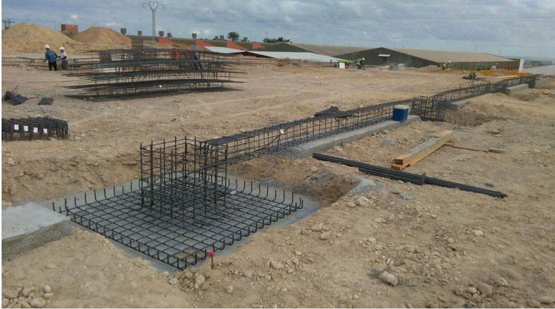
Figura 4.9 Armado de zapatas aisladas con contratraves
