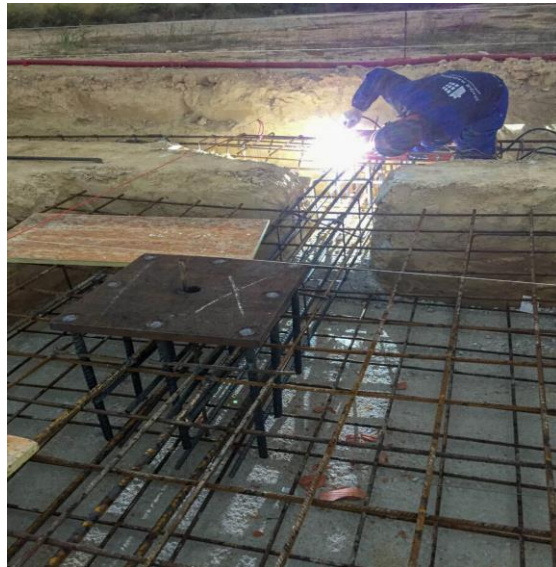
Figura 4.6 Placa unión dado - columna
