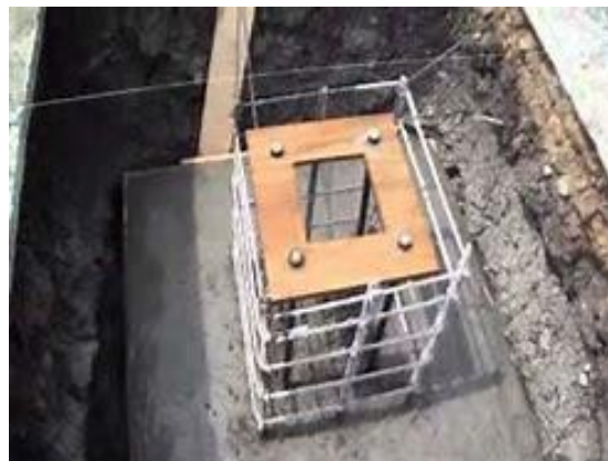
Figura 4.4 Dado de zapata
