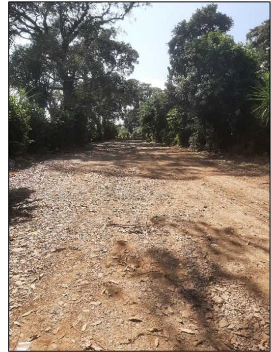
Fig. 59 Calle Julián Gutiérrez terminada.
