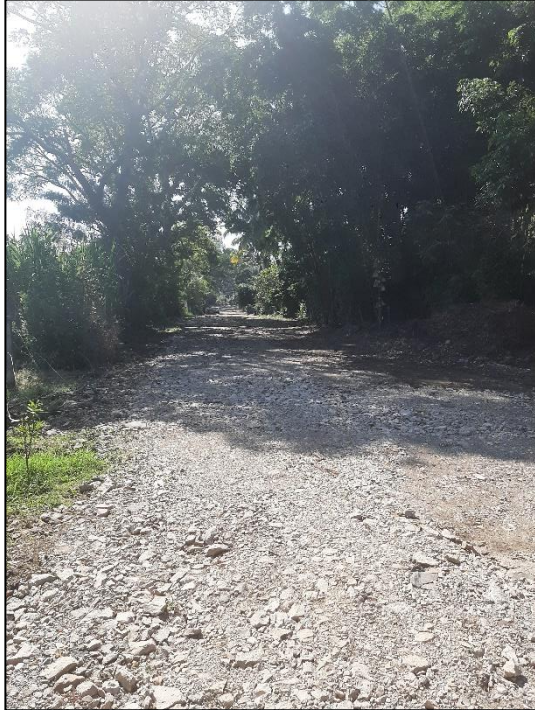
Fig. 62 Calle Julián Gutiérrez terminada.
