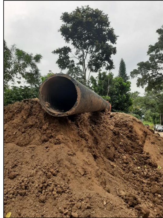
Fig. 61 Tubos utilizados para la segunda rehabilitación del sistema de drenaje sanitario.
