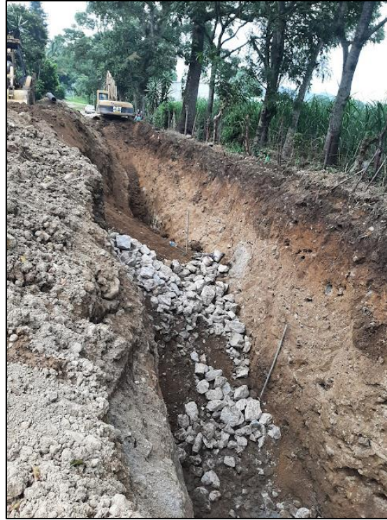
Fig. 56 Zanja donde pasará la línea auxiliar propuesta para el proyecto. Fuente: Elaboración propia.
