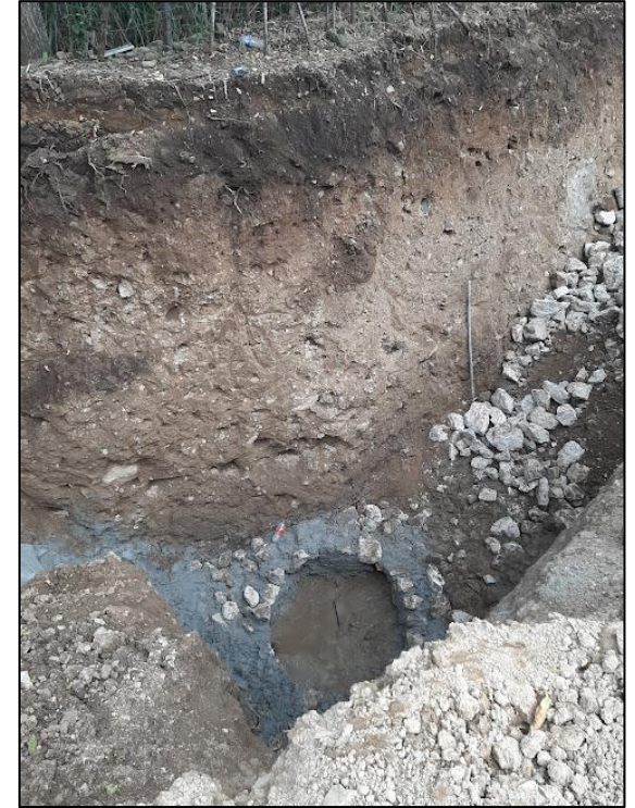
Fig. 57 Construcción de olla que conecta la línea auxiliar y el pozo de visita 14. Fuente: Elaboración propia.
