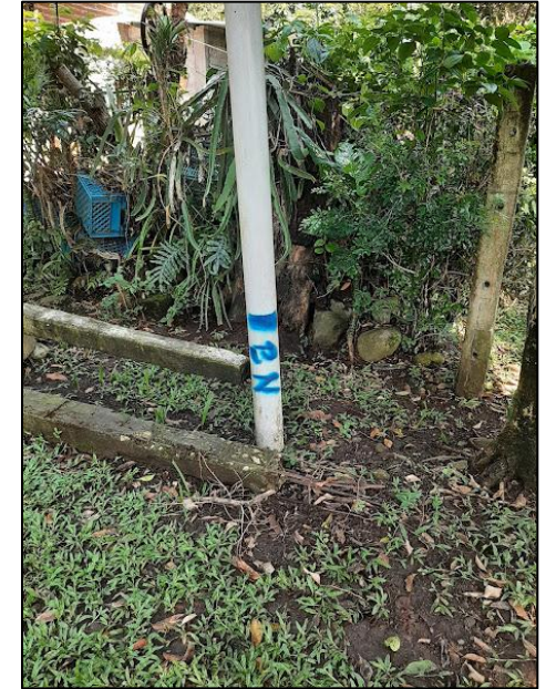
Fig. 52 Establecimiento de bancos de nivel para la pendiente de la tubería. Fuente: Elaboración propia.
