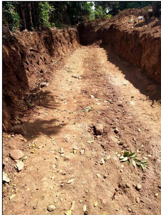
Fig. 39 Excavación de zanja para instalación de tubería nueva.
