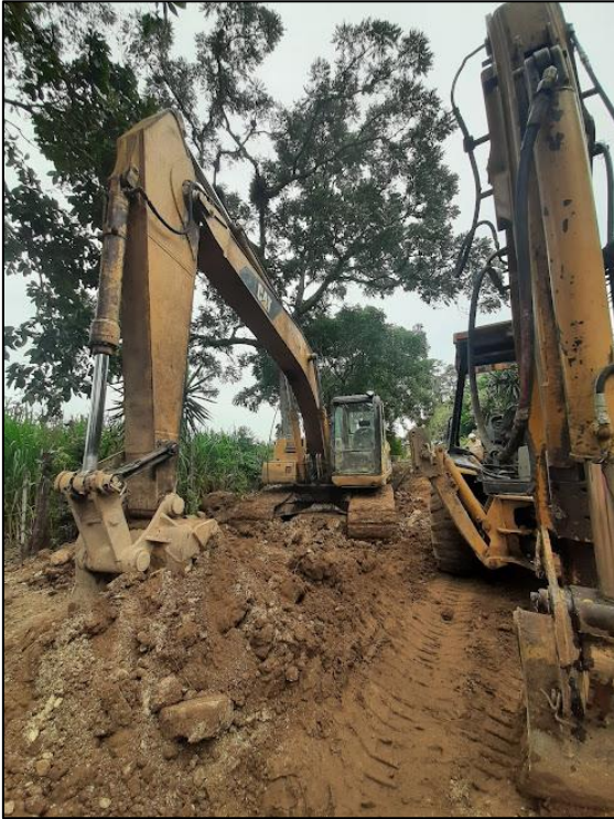
Fig. 55 Maquinaria pesada utilizada para las excavaciones del proyecto. Fuente: Elaboración propia.
