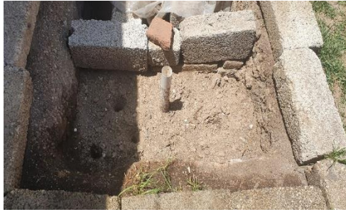
Ilustración 20 Elaboración de hoyos para mejorar la infiltración de agua y aire
