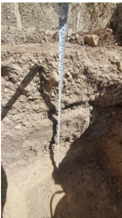
Ilustración 11 Verificación de la profundidad de la excavación
