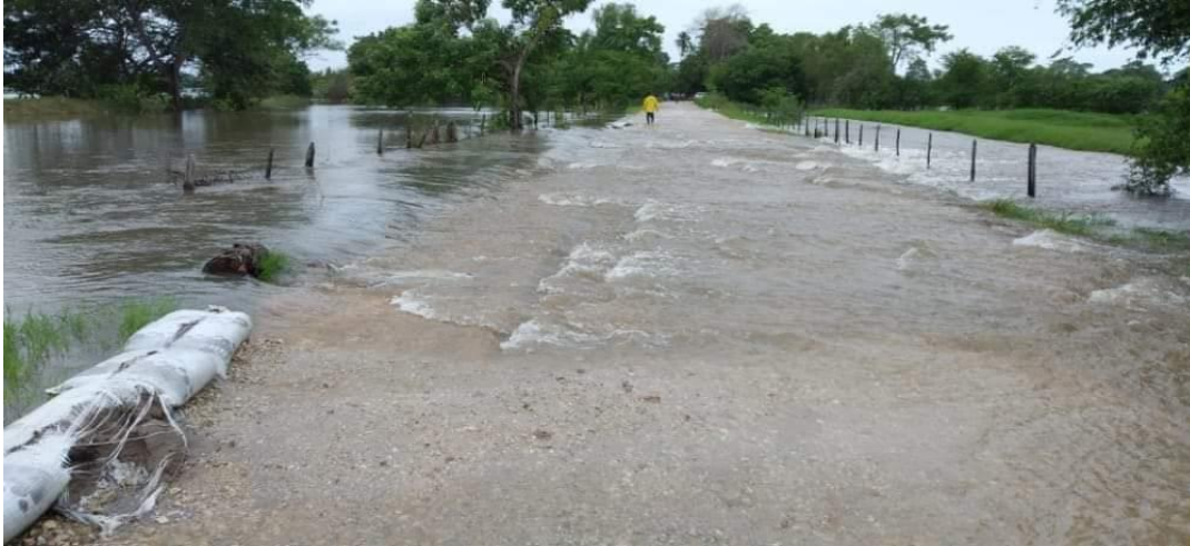
Ilustración 27. Desbordamiento del Rio Santa Ana en la Ranchería El Golpe, Cárdenas, Tabasco. Trabuco Noticias, 2021.
