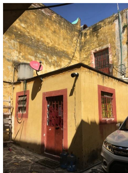
Figura 13. Fotografía del interior de una vecindad, se puede apreciar la primera pieza de aproximadamente de 2 metros por 2.5 metros, no se encuentra en buenas condiciones, pero cuenta con antena de cable Dish. Fotografía de la autora.
