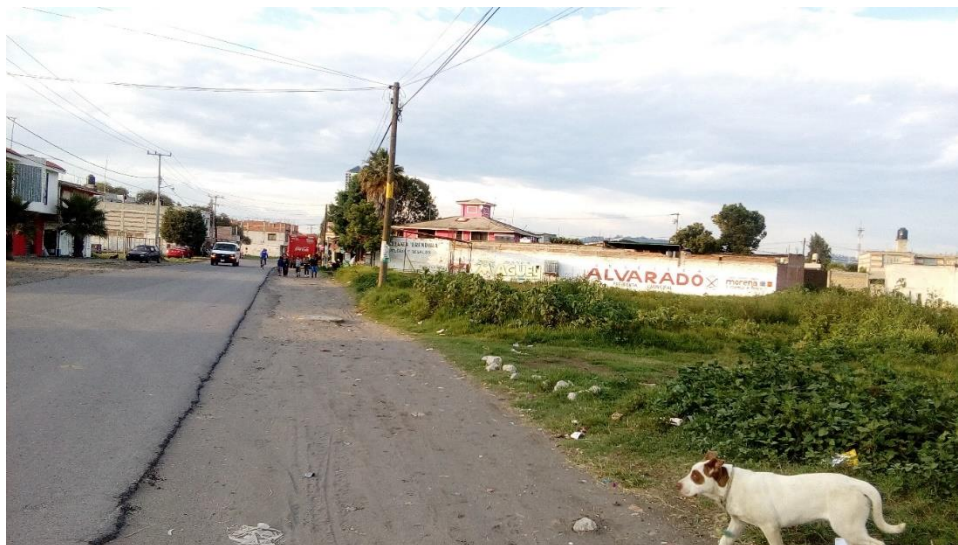
Figura 14. Ancho de la banqueta de 2.50 metros aproximadamente en algunos tramos lo cual no es viable.
