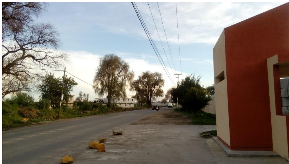
Figura 17. Entrada y acceso al plantel F-18.
