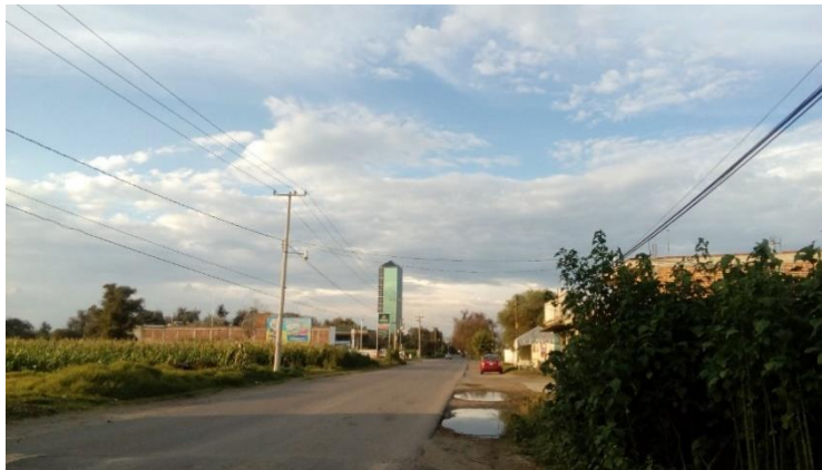
Figura 21. La banqueta es de tipo terracería, presenta gran deterioro y se ve afectada por las inundaciones.
