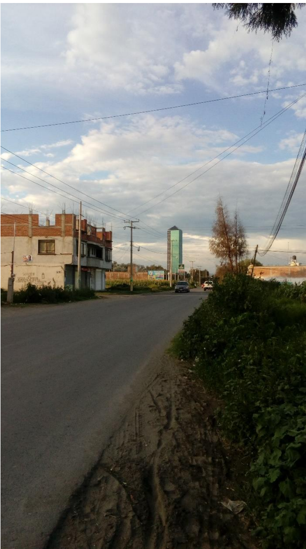
Figura 36. Existen tramos de la avenida donde no existe banqueta y el peatón se ve obligado a caminar sobre la vialidad.
