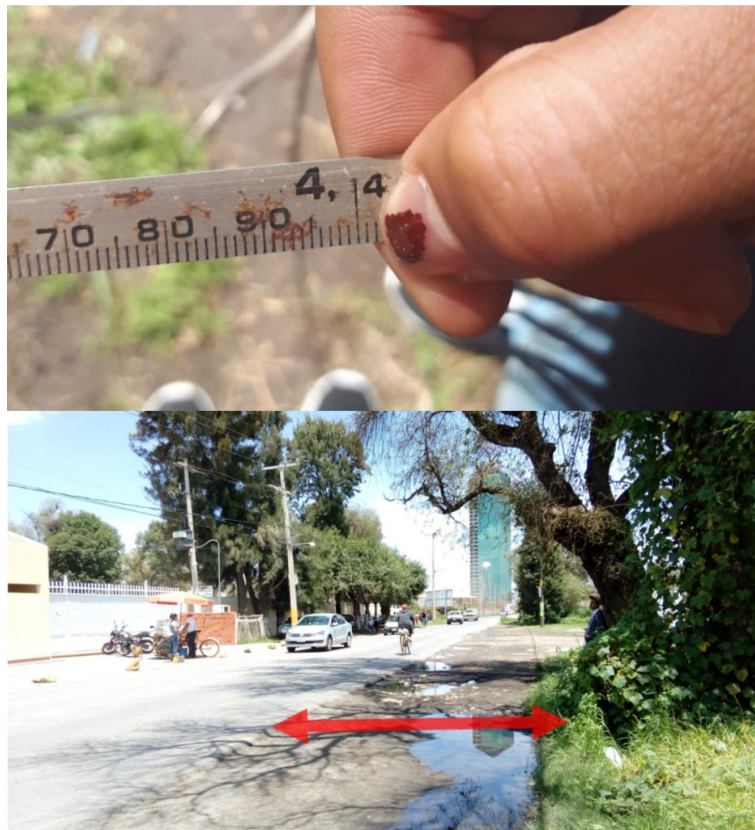
Figura 16. Ancho de banqueta de 4.40 metros
