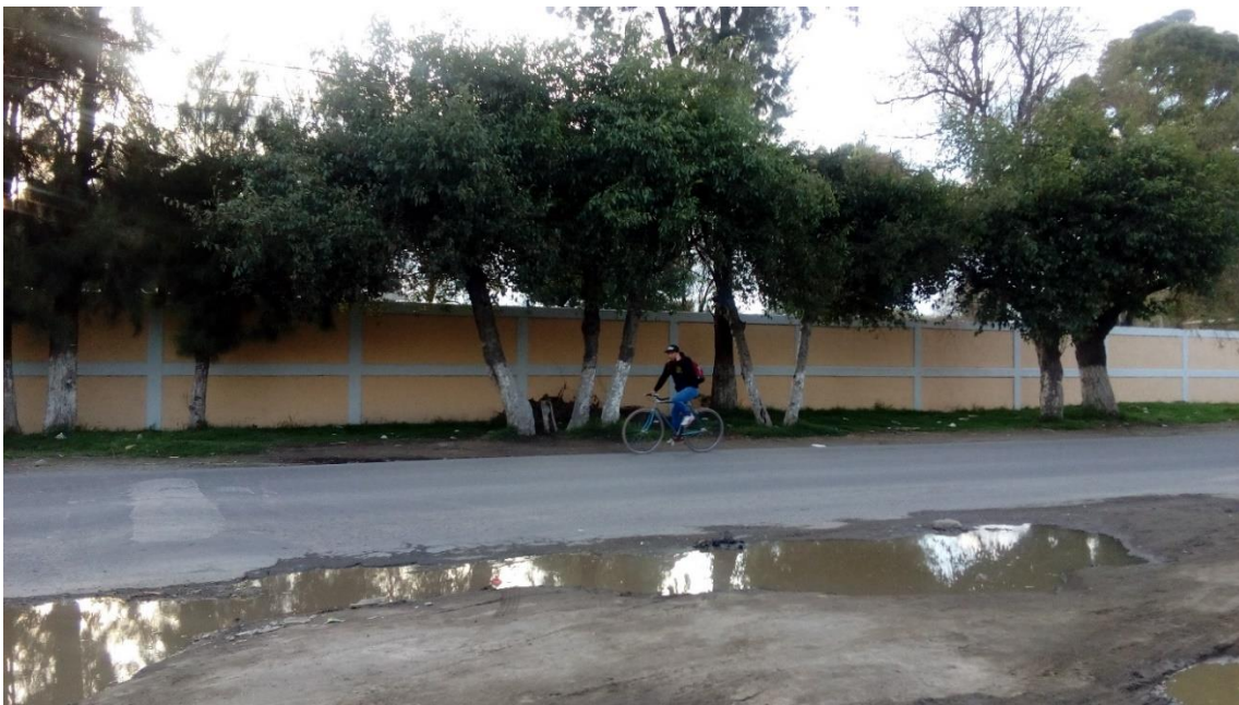
Figura 35. Las banquetas presentan graves inundaciones lo cual no permite un tránsito seguro para los peatones.
