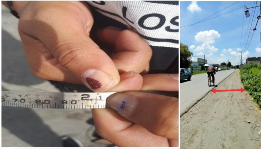
Figura 15. Ancho de la banqueta 2.1 metros.
