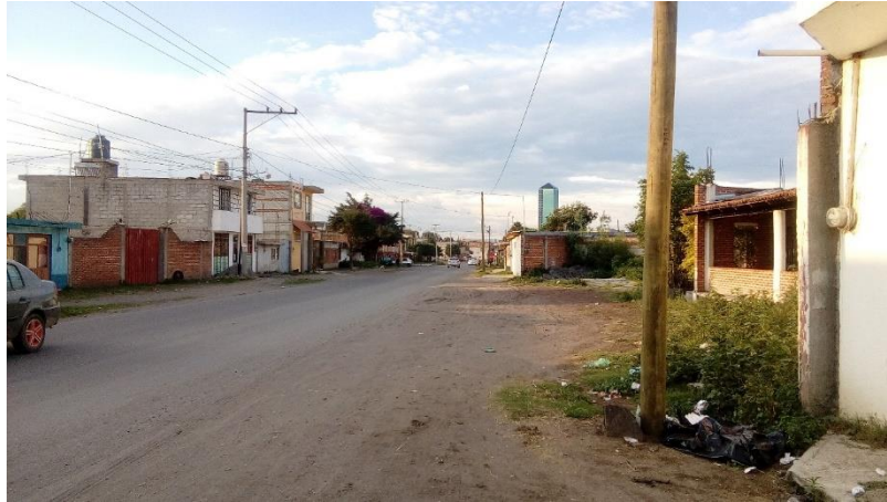
Figura 28. Tramo en malas condiciones.
